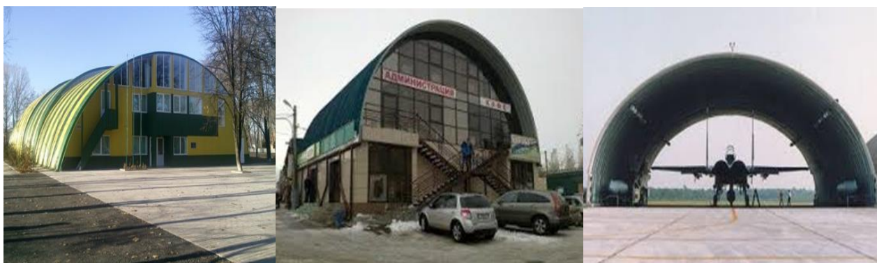
Рис. 1. Оболочечные конструкции из холоднодеформированных тонкостенных профилей
