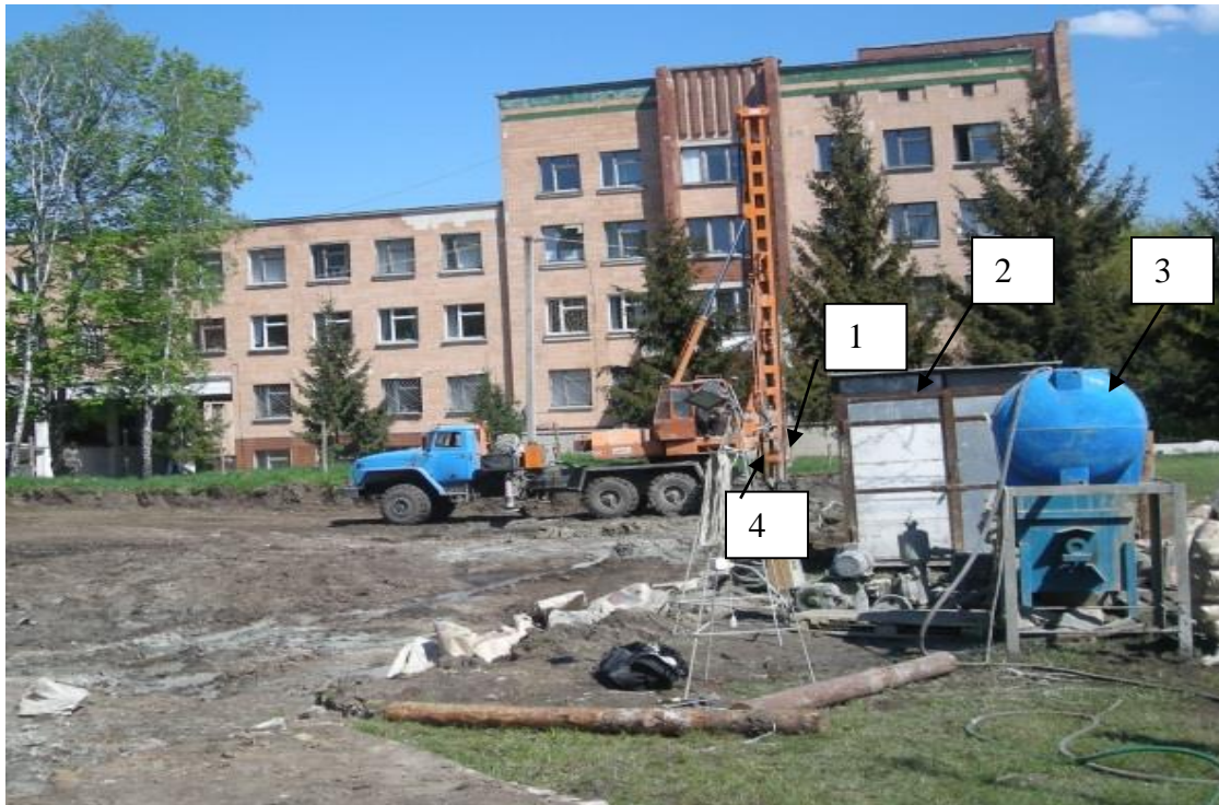
Рис. 5 Загальний вигляд комплексу обладнання для виготовлення ґрунтоцементних елементів за бурозмішувальною технологією: 1 – буровий верстат; 2 – схованка для розчиномішалки, розчинонаосу, склад цементу; 3 – ємність для води; 4 – напірний шланг
