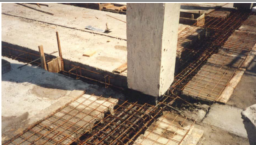
Рис. 3. Сполучення плит і ригелів перекриття системи «АРКОС»
