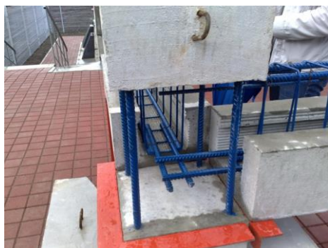
Рис. 1 Вузол з'єднання ригеля з крайньою колоною в ЗМК Сарет
