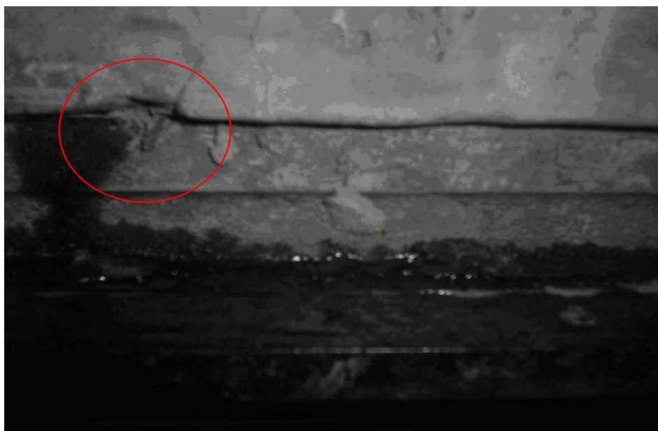
Рис. 4 Локальне руйнування прокладного шару з Emaco Fast Fluid в місці концентратора напруги – тріщини в залізобетонній плиті БМП
