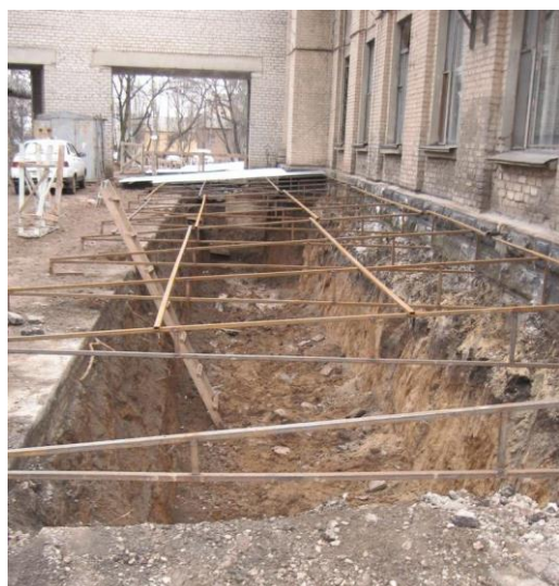
Рис. 3. Загальний вигляд траншеї уздовж стіни будинку
