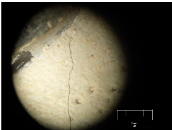
Рис. 4. Фрагмент трещины 1 из рис. 3, а (увеличение \times 25 )
