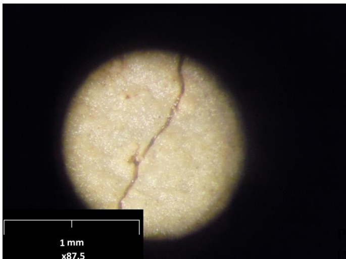
Рис. 6. Фрагмент трещины 3 из рис. 3, а (увеличение \times 87,5 )
