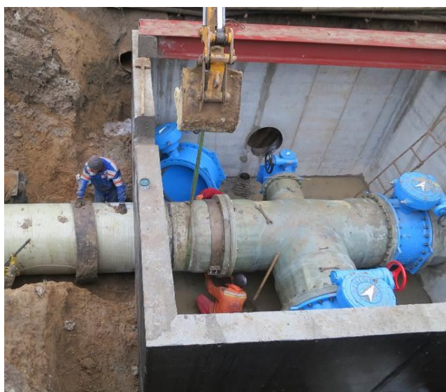
Рис. 5. Раструбное соединение стеклопластиковых труб в камере
