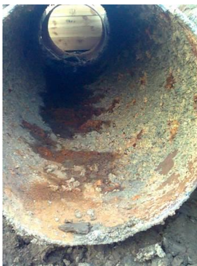
Рис. 1. Внутренняя стенка стального водовода диаметром D_y=700 мм со следами инкрустации и внутренней коррозии
