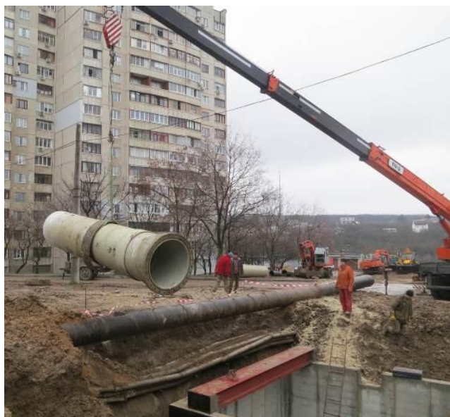
Рис. 2. Монтаж стеклопластиковой трубы
