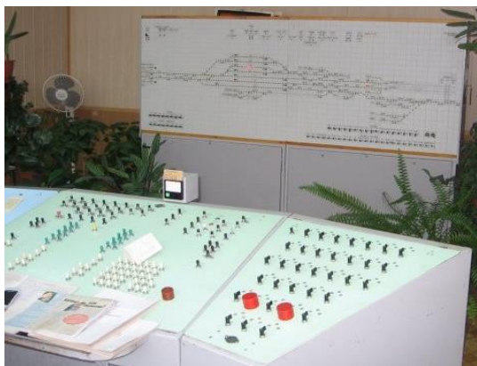
Рис. 2. Пульт-маніпулятор з виносним табло
