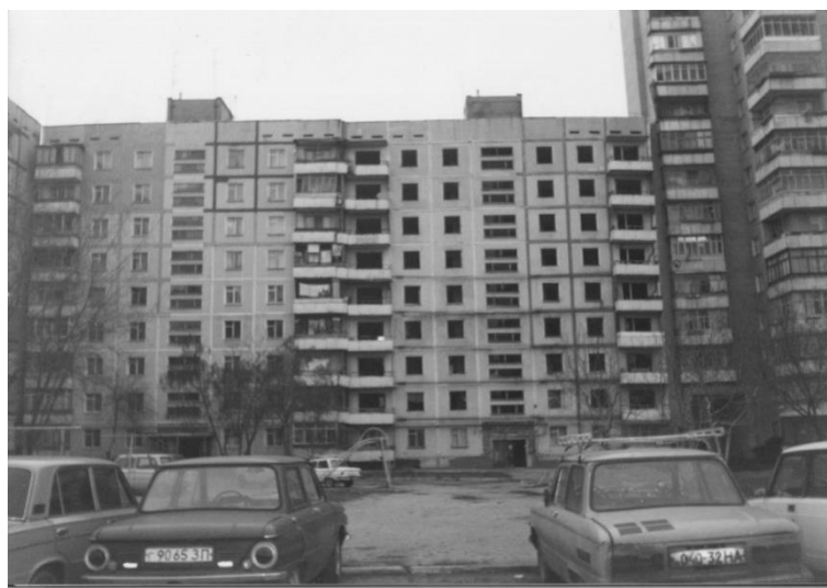
Рис. 1. Аварийное состояние блок-секции вследствие сталкивания смежных строений из-за встречных кренов по ул. Воронежской, ба в г. Запорожье
