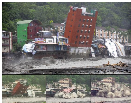
Рис. 7. Явный отрыв грунта из-под дома и его вынос в реку [7]
