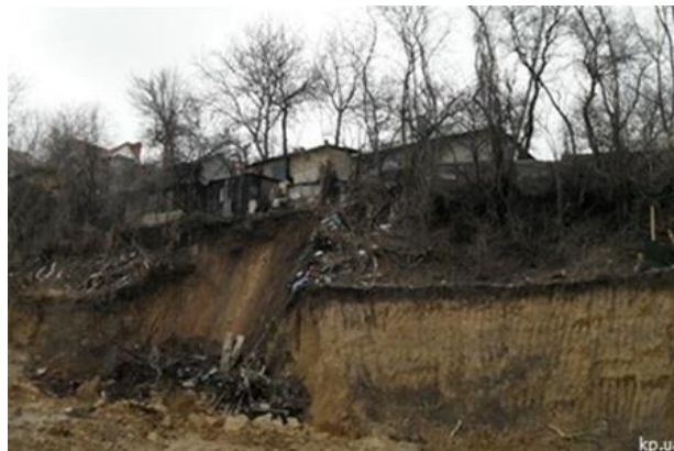
Рис. 9. Оползни на Батыевой горе г. Киев [9]
