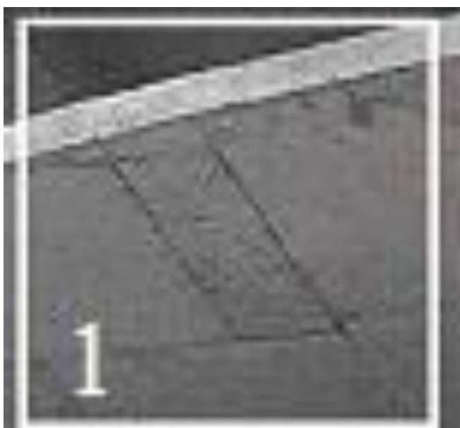
Рис. 7. Збільшений фрагмент 1 і 3. Ознаки утворення початкових тріщин повздовж арматури у плитах перекриття і колонах
