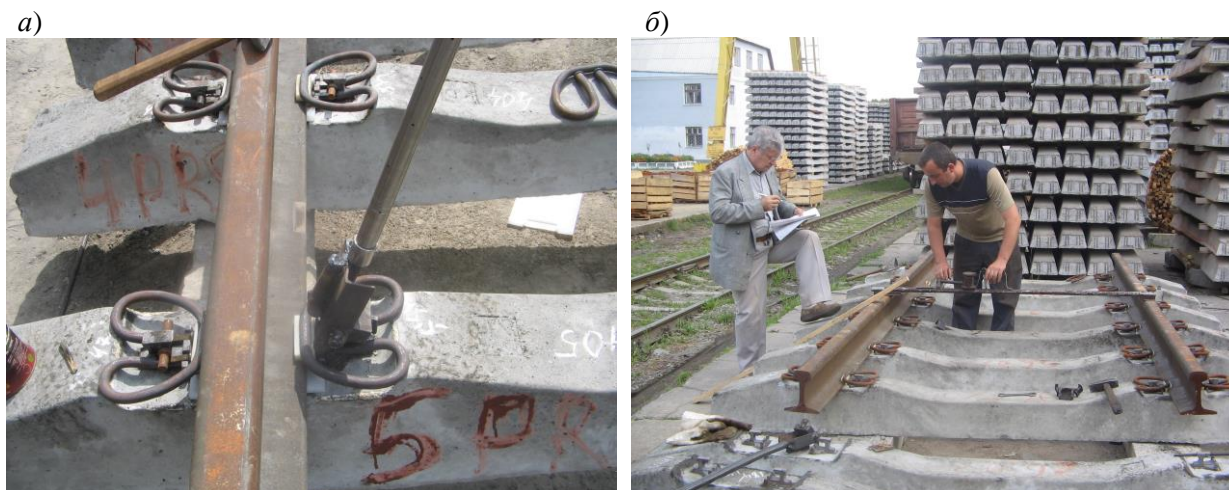
Рис. 12. Збирання ланки на шпалах ШІ1-1-PRS: а – замикання скріплення ключем; б – контроль ширини колії – 1520 мм забезпечено
