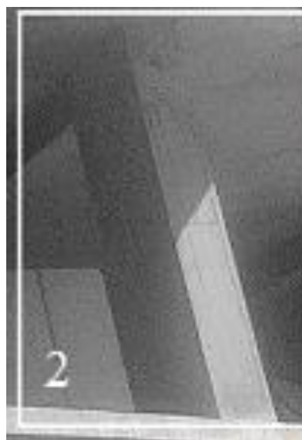
Рис. 7. Збільшений фрагмент 1 і 3. Ознаки утворення початкових тріщин повздовж арматури у плитах перекриття і колонах
