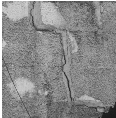
Рис. 6. Деформації в конструкціях лежаків
