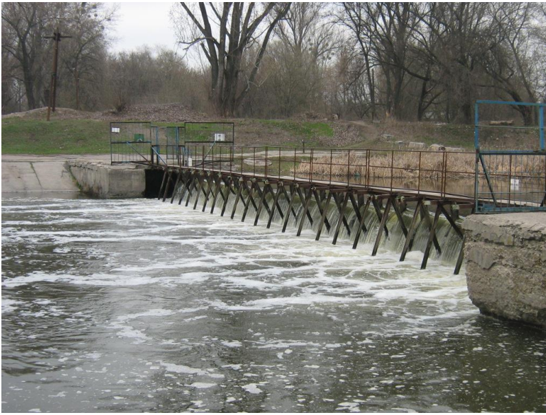
Рис. 2. Лопанский гидроузел: а – вид на плотину с нижнего бьефа ГУ; б – перелив воды через деревянные щиты «Буле», опертые на металлические фермы «Поаре»
