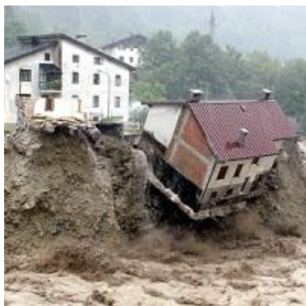
Рис. 6. Отвесный оползень под домом [6]
