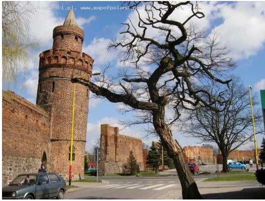
Рис. 19. Совиня башня фортечних стін, м. Пиржице, Польща
