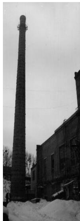
Рис. 2. Димова труба Н=60 м Львівського скляного заводу
