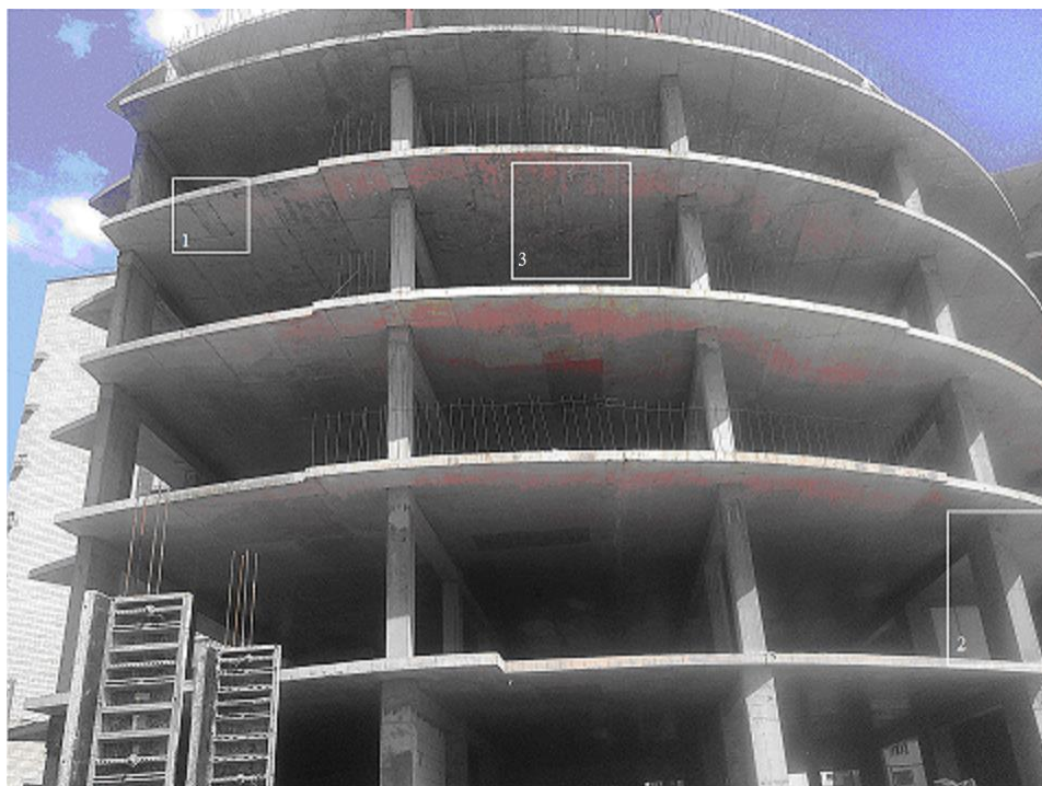
Рис. 6. Існуючий стан будівлі на 21.06.14 р.
