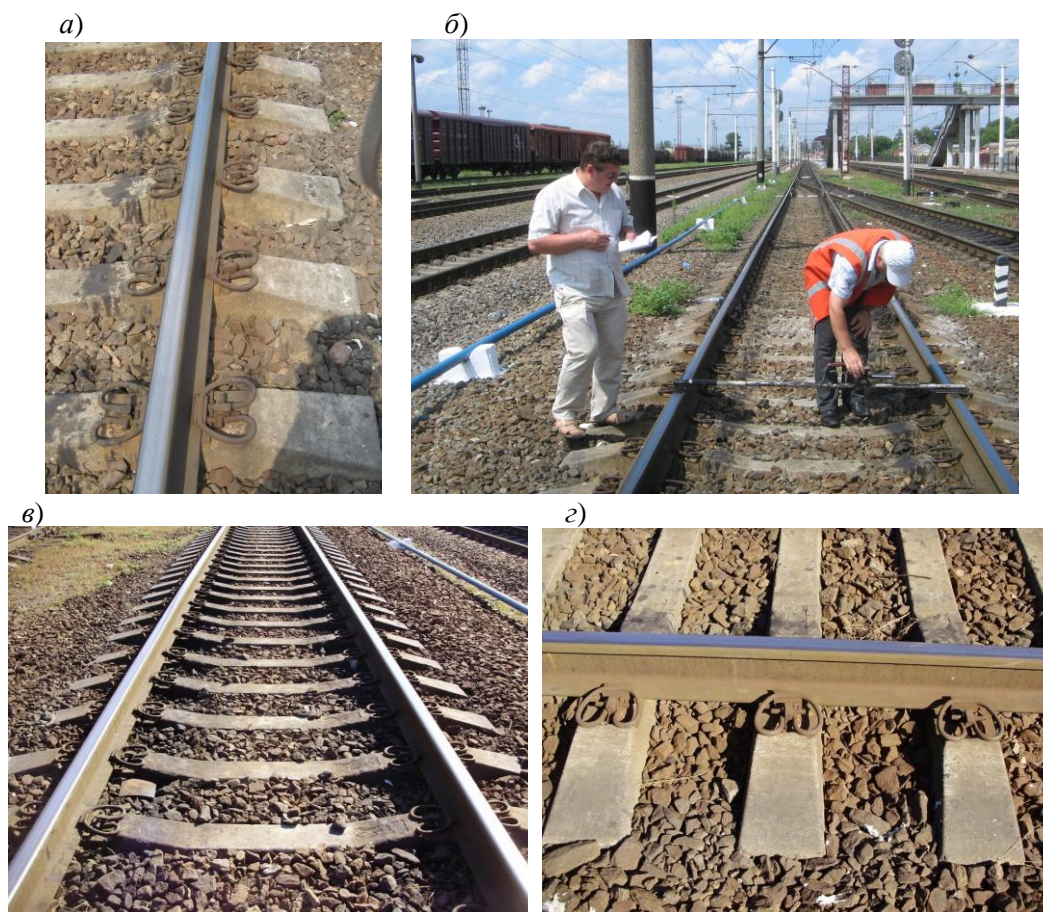
Рис. 10. Рейкові скріплення УС-1 в непарній колії 249 км ПК1 ділянки Основа – Букине Південної залізниці (між стрілочними переводами 550 і 572 станції Основа): а, б – через 9 років експлуатації (06.07.2011, ширина колії – 1518–1522 мм, перекид – не більше 2 мм); в, з – через 12 років експлуатації (05.10.2014, пропущений тоннаж – 259,3 млн. т бруто)
