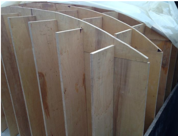
Рис. 10. Комірчаста система, споруджена над оболонкою
