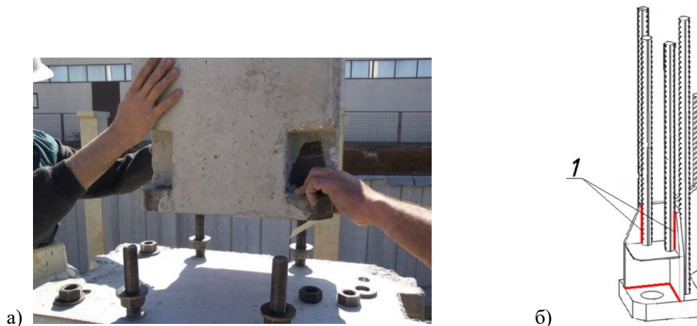
Рис. 1. Загальний вигляд (а) і конструкція (б) закладної деталі система кріплення залізобетонних колон: 1 – зварні шви
