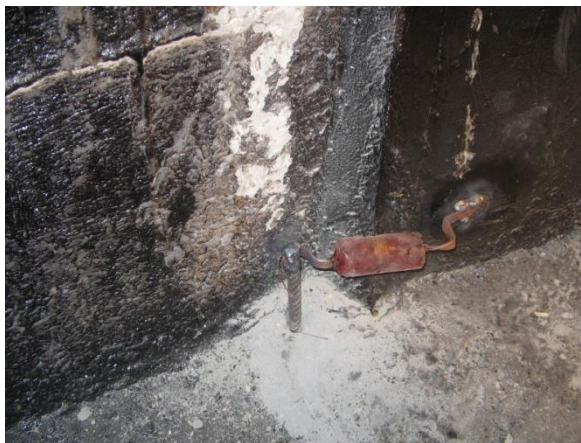
Рис. 10. Діодне заземлення металін'єкційної сорочки бетонної опори пасажирської платформи: 1 – металін'єкційна сорочка; 2 – діод Д231Б або Д232Б; 3 – заземлюючий стержень
