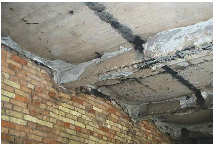
Рис. 3. Тріщини в місцях спирання балок на стіни
