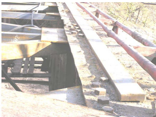
Рис. 5. Ремонтное восстановление верхнего строения пути
