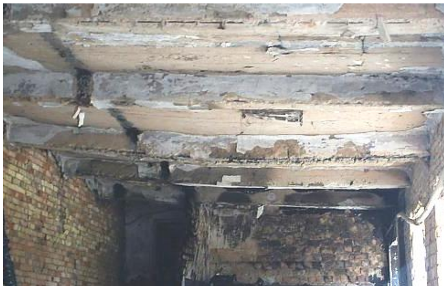
Рис. 2. Вигляд тріщин у місцях спирання балок на стіну по ряду 7
