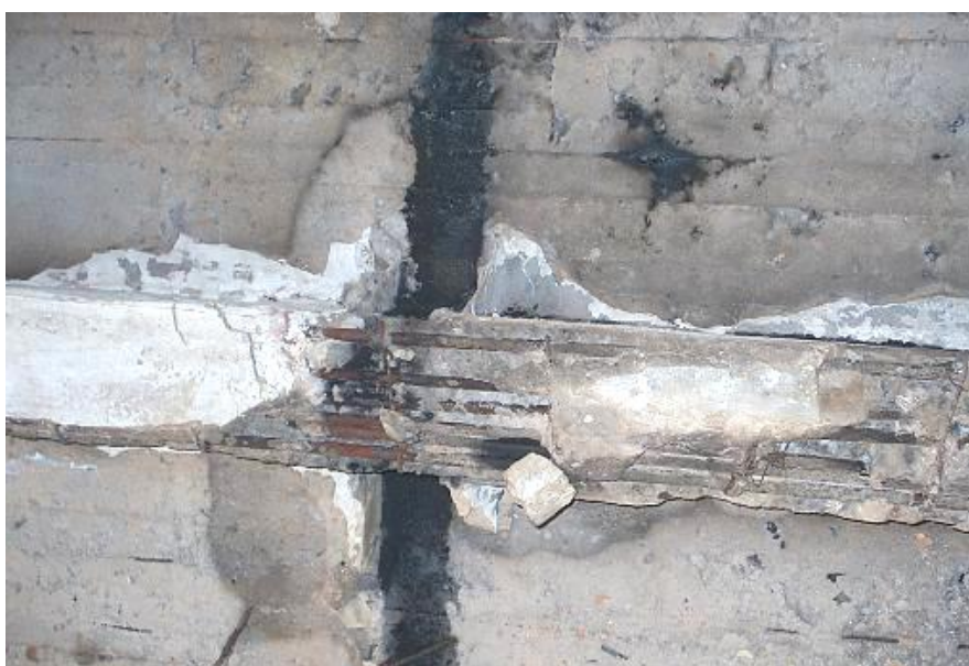
Рис. 4. Порушення захисного шару бетону із оголенням робочої арматури
