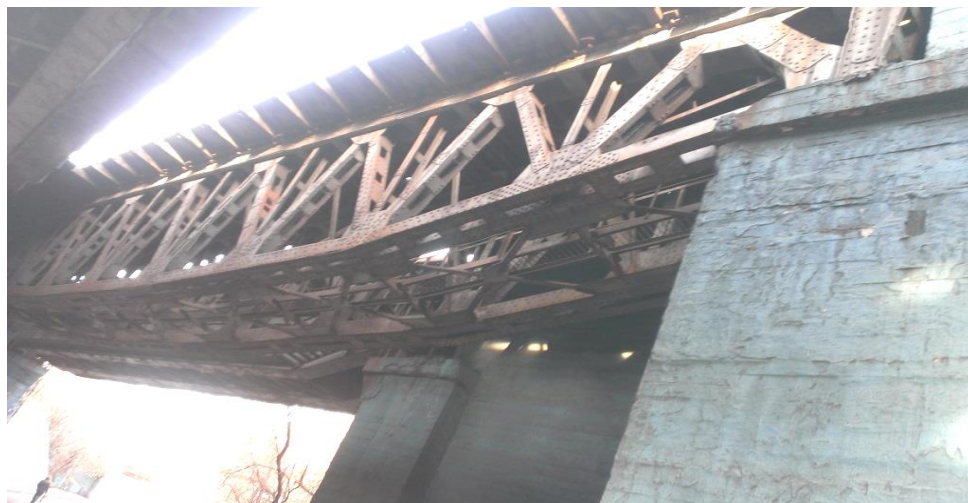
Рис. 4. Общий вид пролетного строения
