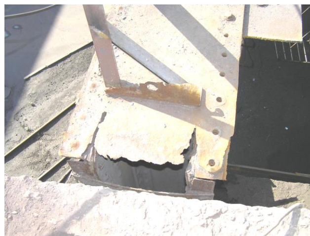
Рис. 6. Коррозионное разрушение узлового соединения опорного участка
