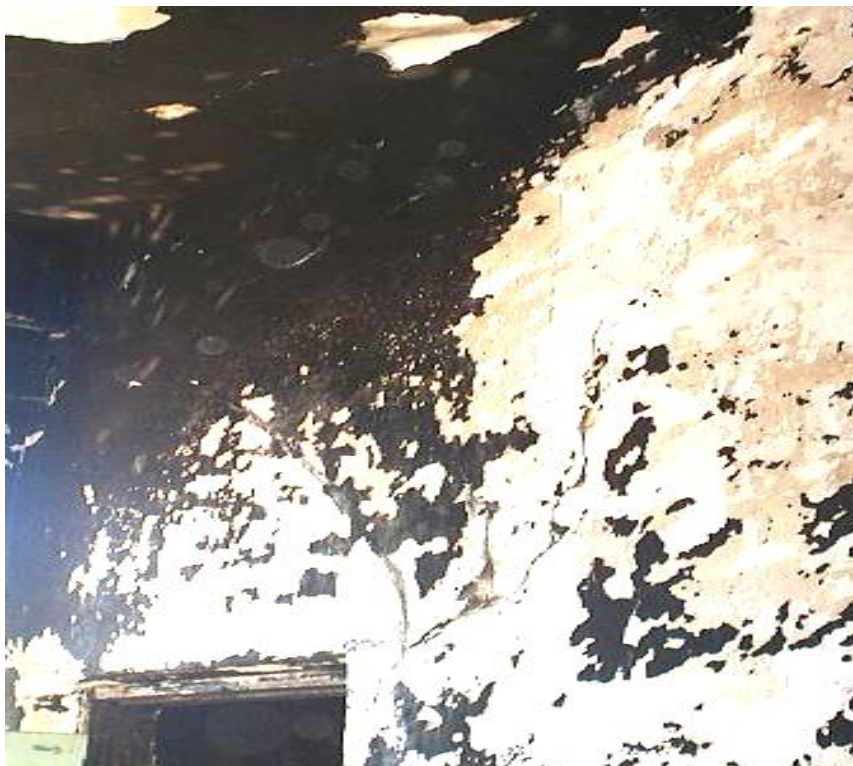
Рис. 5. Тріщини в поперечній стіні біля входу у приміщення другого поверху
