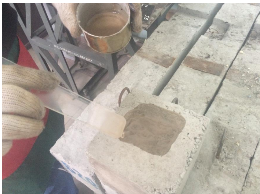
Рис. 5. Нанесение растворной смеси ПММА на поверхность бетонного образца марки С16/20 в лаборатории кафедры строительных конструкций ХНУГХ имени А.Н. Бекетова
