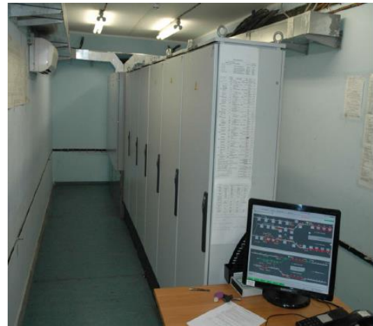
Рис. 3. Блокове приміщення МПЦ
