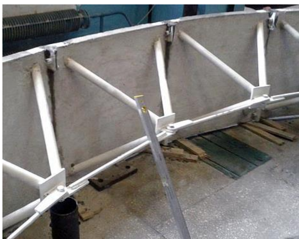
Рис. 6. Збирання просторової структурно-вантової сталезалізобетонної конструкції
