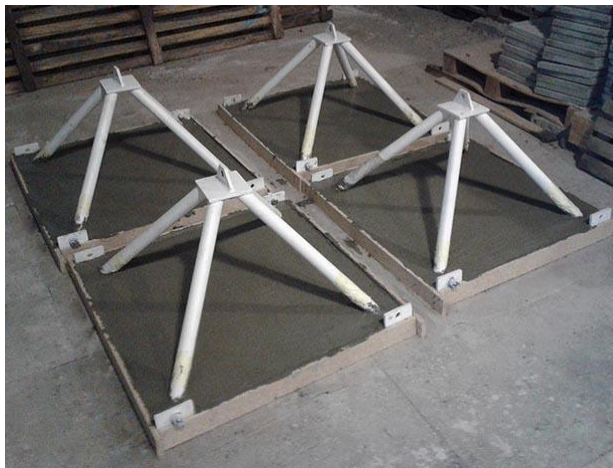
Рис. 5. Бетонування верхнього пояса просторового сталезалізобетонного модуля
