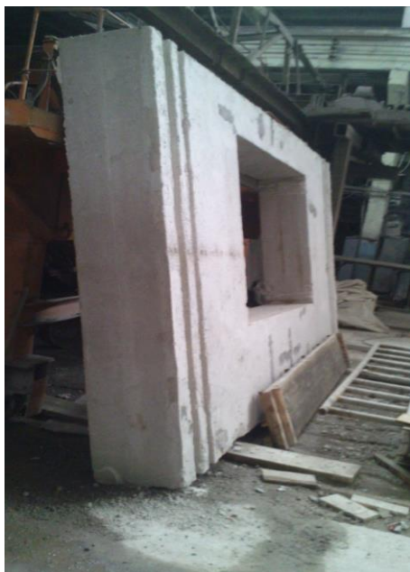
Рис. 2. Стінова панель фасадна
