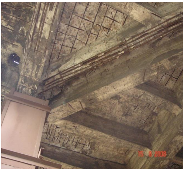
Рис. 1. Пошкодження залізобетонної прогонової споруди шляхопроводу № 11а ПАТ «ММК «Азовсталь» (м. Маріуполь)
