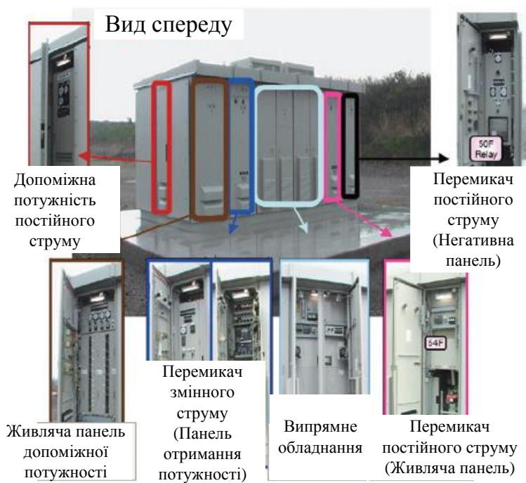
Рис. 2. Приклад тягової підстанції постійного струму комплектно-блочного типу
