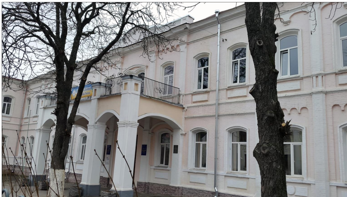
Рис. 3. Фасад здания Мариинской гимназии после ремонта
