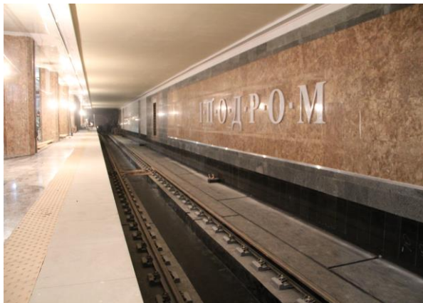
Рис. 8. Збірно-монолітні залізобетонні підрейкові основи з ізованими блочними опорами в станційних тунелях Київського метрополітену: а – ст. Виставковий центр; б – ст. Іподром
