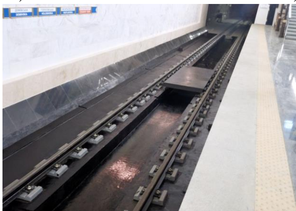
Рис. 8. Збірно-монолітні залізобетонні підрейкові основи з ізованими блочними опорами в станційних тунелях Київського метрополітену: а – ст. Виставковий центр; б – ст. Іподром
