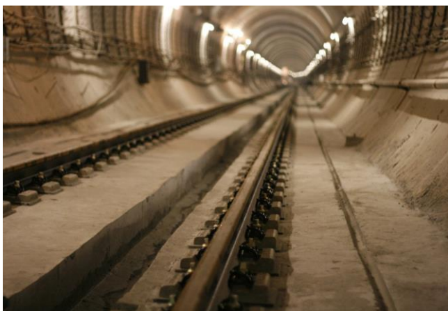
Рис. 7. Експериментальна ділянка на ізованих блочних опорах EBS виробництва фірми Tines (Польща) на 1-й колії Куренівсько-Красноармійської лінії Київського метрополітену
