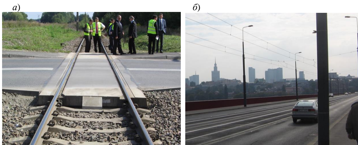
Рис. 4. Залізобетонні підрейкові основи з ізолювальною рейкою, укладеною в жолоб: а – збірна на залізничному переїзді (Польща); б – монолітна на трамвайних коліях (м. Варшава, Польща)
