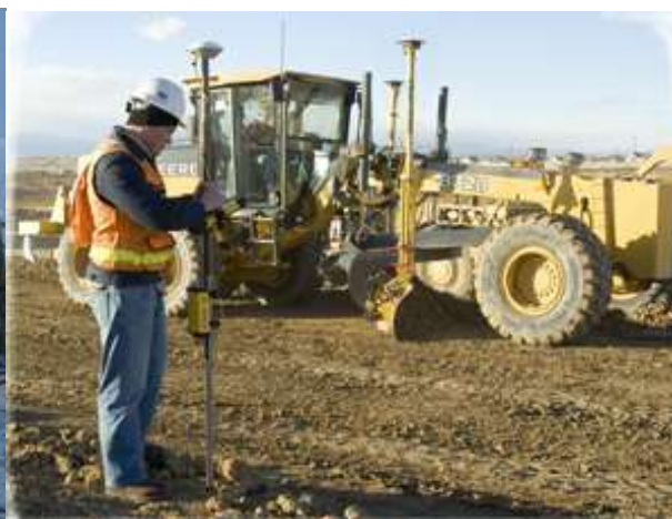
Системи позиціонування для будівництва (SPS - Site Positioning Systems)
