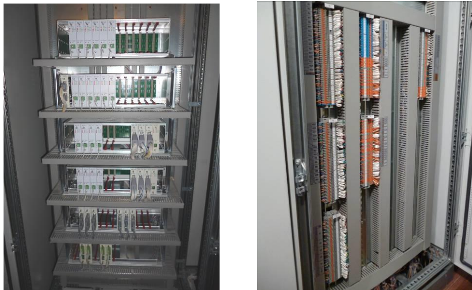
Рис.4 - Шафа мікропроцесорних контролерів зв'язку та введення-виведення інформації (Ш-КС-01)
