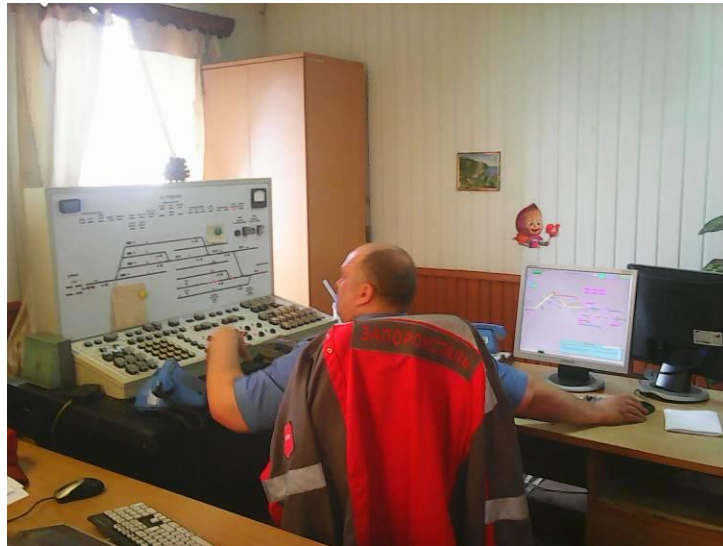
Рис.1 Робоче місце чергового по станції «Рудна»
