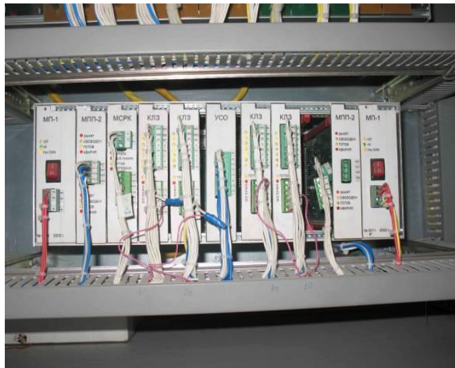
Рис. 1. Система напівавтоматичного блокування на базі підрахунку осей рухомого складу з передаванням керуючої інформації по радіоканалу
