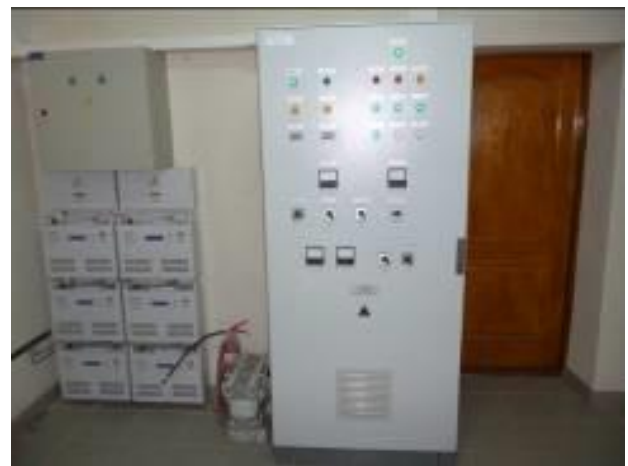
Рис.2. Обладнання МПЦ станції «Транзитна»
