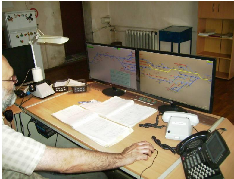
Рис.1 Робоче місце чергового по станції
