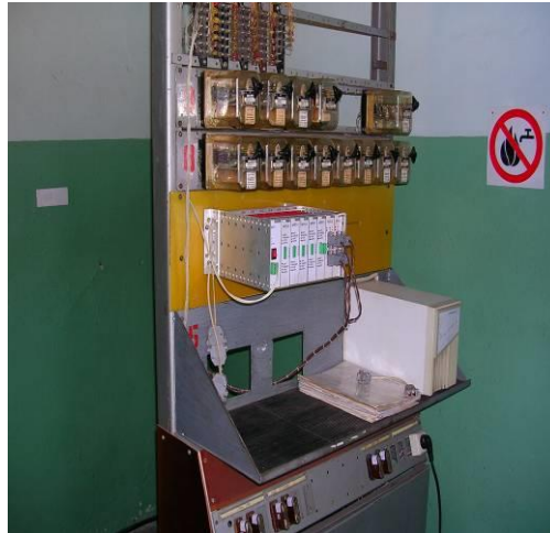
Рис.2. Автоматична переїзна сигналізація на базі мікропроцесорної системи підрахунку осей рухомого складу
