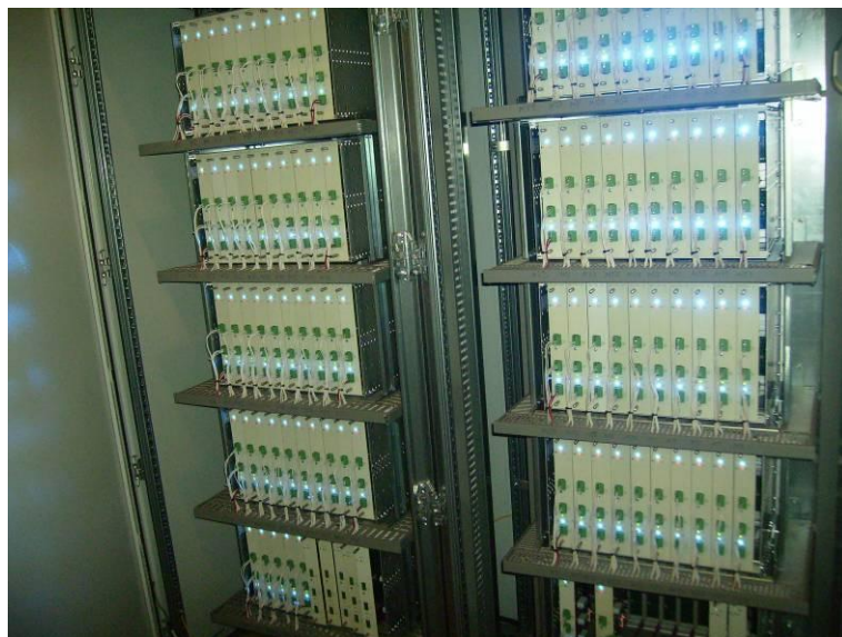
Рис.3 Шафи керування та мікропроцесорні контролери комп'ютерної системи централізації стрілок та сигналів
