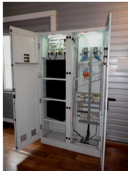
Рис.10. Спеціалізований для МПЦ щит аварійного вимкнення електроживлення ЩВПУ-М
