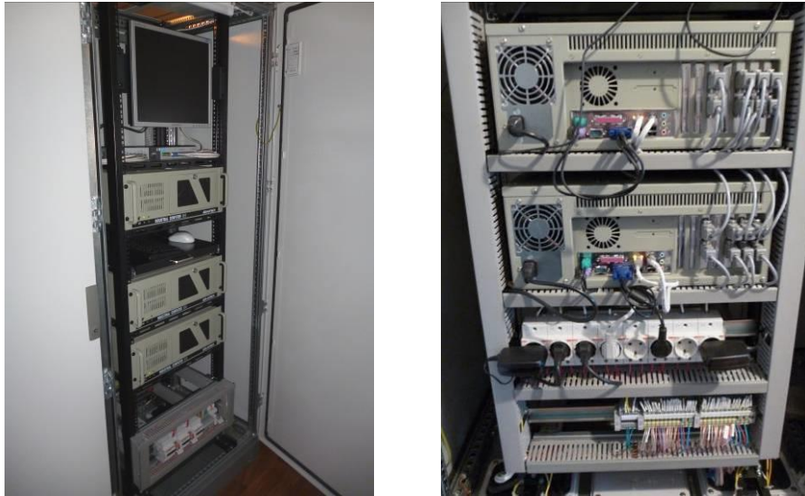
Рис.3. Комп'ютерний центр обробки інформації та безпечного керування стрілками та сигналами – шкаф ЕОМ залежностей МПЦ
