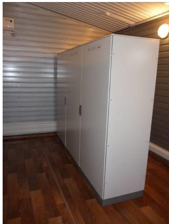
Рис. 8. Шафи ЕОМ керування, мікропроцесорних контролерів та електроживлення МПЦ – потрібна потужність та площа для розміщення обладнання у десятки разів менша, ніж для релейних систем
