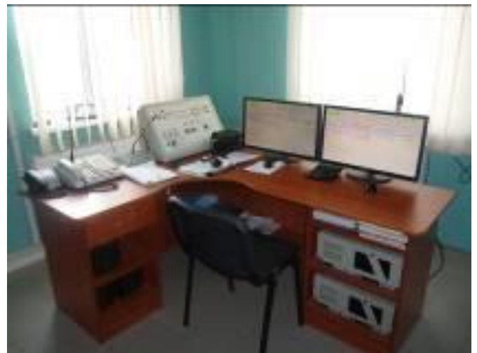
Рис.1 Пост керування МПЦ та АРМ чергового по станції
