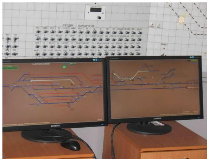
Рис. 1. Система напівавтоматичного блокування на базі підрахунку осей рухомого складу з передаванням керуючої інформації по радіоканалу
