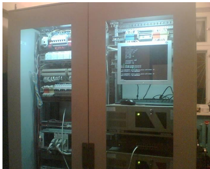
Рис.1. Комп'ютерна централізація стрілок та сигналів на базі системи підрахунку осей рухомого складу
