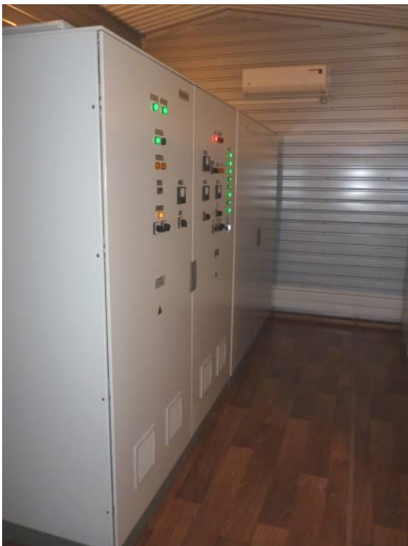
Рис. 8. Шафи ЕОМ керування, мікропроцесорних контролерів та електроживлення МПЦ – потрібна потужність та площа для розміщення обладнання у десятки разів менша, ніж для релейних систем
