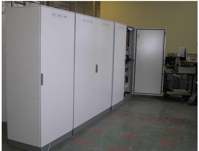
Рис. 3. Автоматизовані робочі місця чергового по станції та електромеханіка, шафи керування МПЦ
