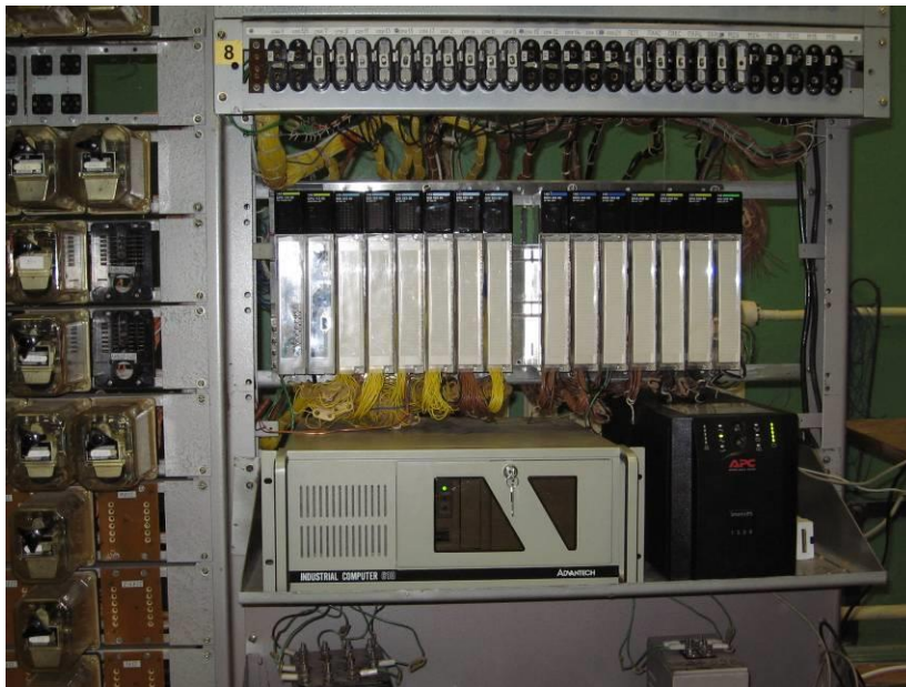
Рис.1 Комп'ютерно-релейна система керування стрілками та сигналами станції «Вапняна»
