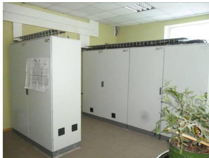
Рис.3 Розміщення шаф керування МПЦ станції «Передача-Донецьк» – значна економія площі для розміщення обладнання та електроенергії
