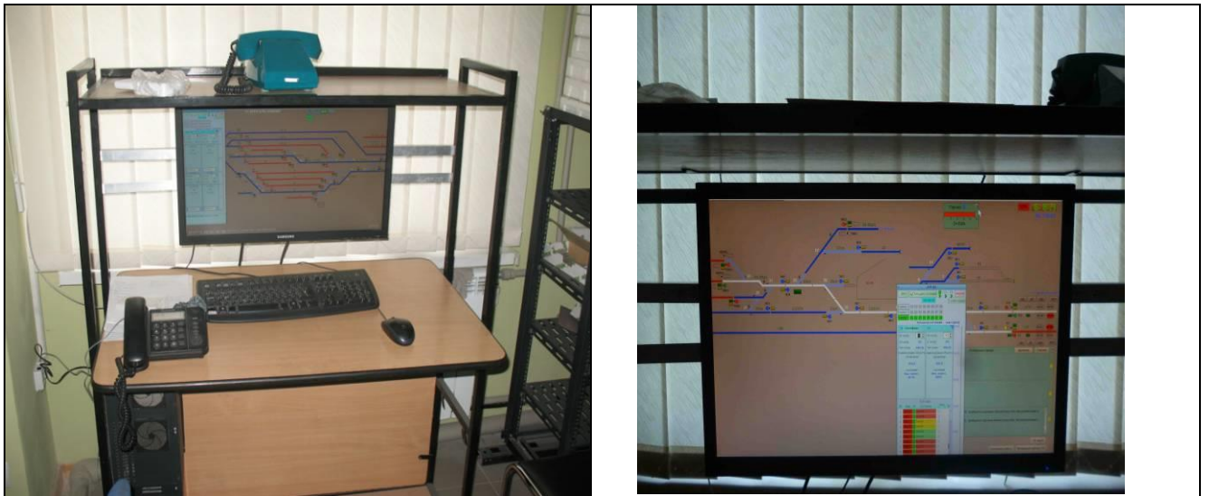
Рис.2 Автоматизоване робоче місце обслуговуючого персоналу станції «Передача-Донецьк»
