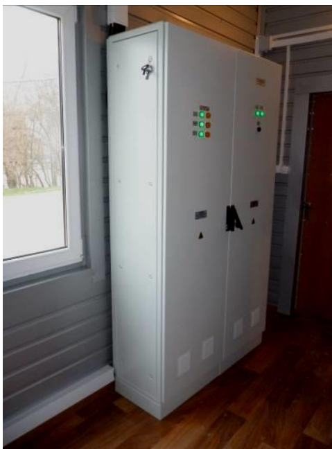
Рис.10. Спеціалізований для МПЦ щит аварійного вимкнення електроживлення ЩВПУ-М
