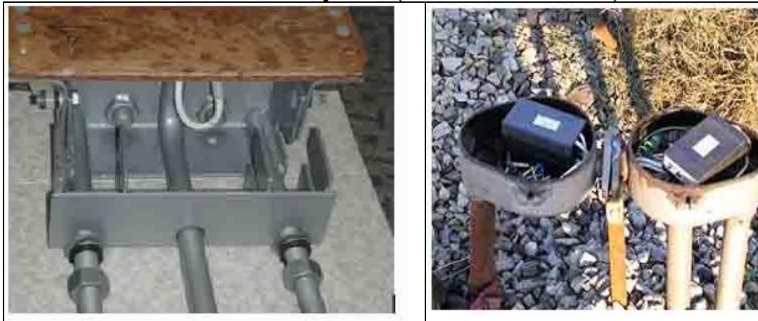
Рис. 7. Рейкові датчики та мікропроцесорні контролери рейкових датчиків системи контролю вільності колійних ділянок методом підрахунку осей рухомого складу
