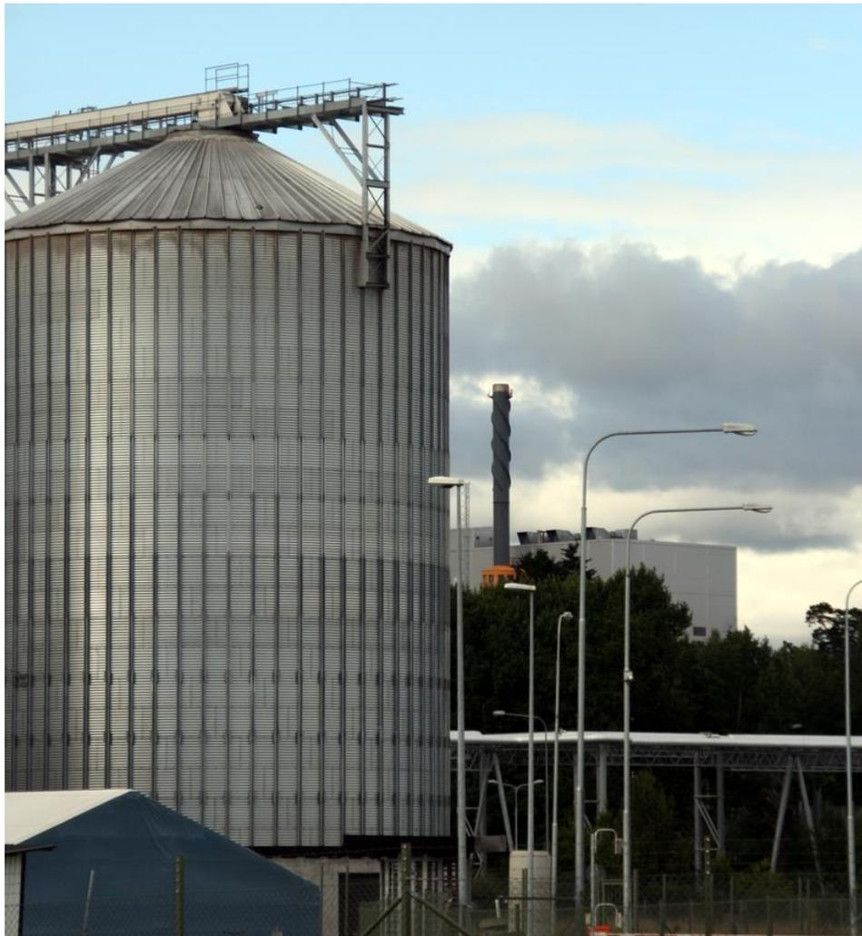
Приклад «промислового симбіозу», де відпрацьована пара зі сміттєспалювального заводу (праворуч) спрямовується на завод з виробництва етанолу (ліворуч), де використовується у виробничому процесі.
