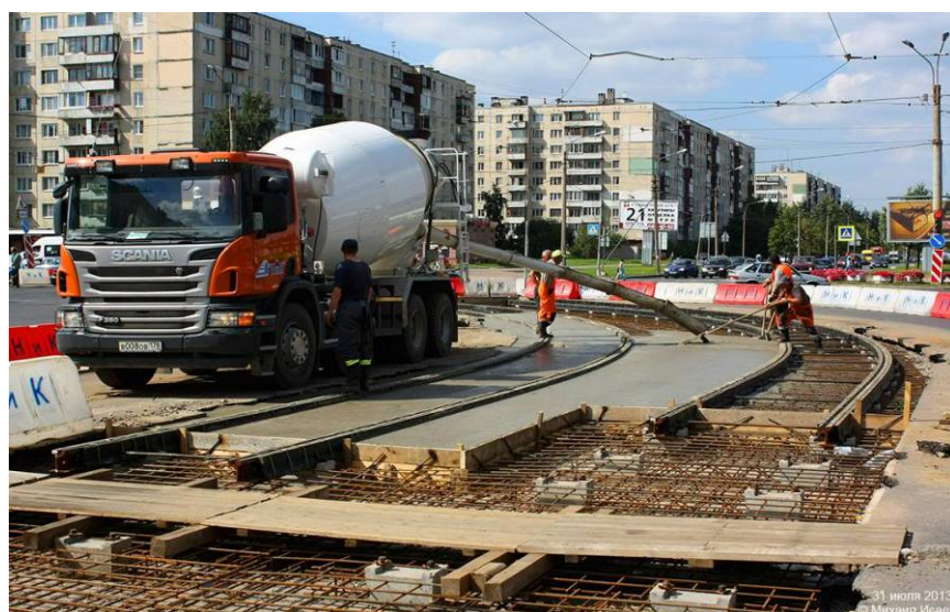
Рис. 5.8. Улаштування трамвайної колії зі збірно-монолітною підрейковою основою із збірних залізобетонних блоків та монолітної плити: a – встановлені у проектне положення рейки та блоки, підготовлені до укладання бетону монолітної плити (м. Харків, вул. Конєва, 2017 р.); б – укладання бетону монолітної плити
