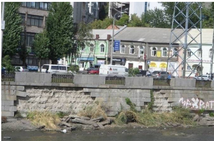
Рис. 3.13. Пошкодження облицювання набережної правого берегу р. Харків: а – біля Харківського мосту (облицювання розібране перед ремонтом); б – біля мосту Чигирина; в – там же, збільшене зображення
