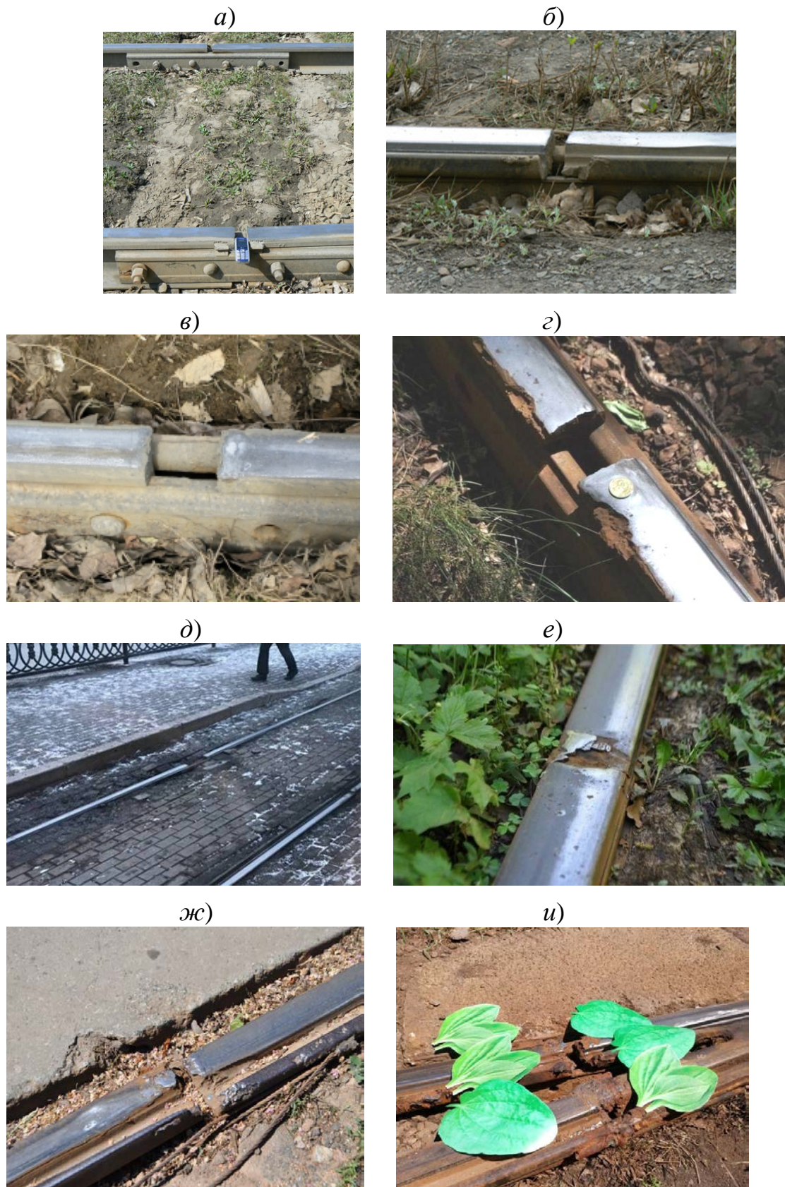
Рис. 1.7. Надмірне розкриття стиків ( a – д ) та розрив зварних стиків ( е – и ): a, б – розкриття понад 20 мм, у т.ч. з відколом жолоба [41]; в – розкриття понад 50 мм, у т.ч. з відколом головки рейок [41]; д – розкриття з відколом головки рейки понад 200 мм [58]; е – и – розрив зварних стиків [59]
