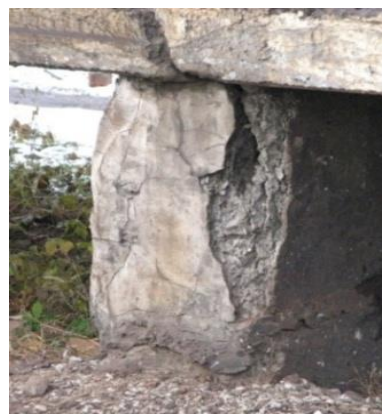
Рис. 3. Електрокорозія бетонних блоків опор високих пасажирських платформ: а – схема протікання струму витoku через конструкції платформ; б – схема перенесення іонів – носіїв струму через обводнений ґрунт і бетон; в – висоли на поверхні опори (з.п. Жовтневий дільниці Харків – Мерефа); г – руйнування бетону опори (з.п. Водяне ділянці Харків – Люботин Південної залізниці)
