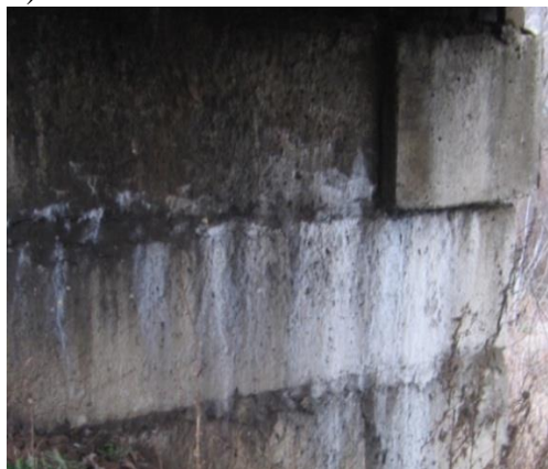
Рис. 3. Електрокорозія бетонних блоків опор високих пасажирських платформ: а – схема протікання струму витoku через конструкції платформ; б – схема перенесення іонів – носіїв струму через обводнений ґрунт і бетон; в – висоли на поверхні опори (з.п. Жовтневий дільниці Харків – Мерефа); г – руйнування бетону опори (з.п. Водяне ділянці Харків – Люботин Південної залізниці)
