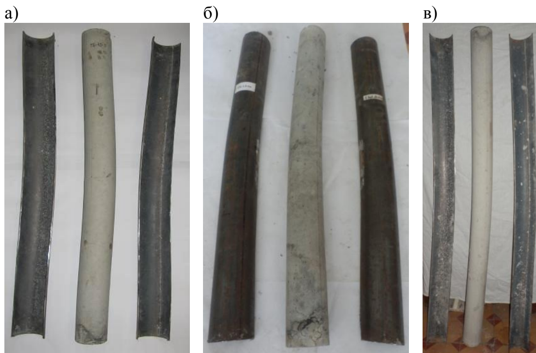
Рис. 4.18. Зовнішній вигляд бетонного ядра і сталевій оболонки після демонтажу гнучких колон: а - колона серії ТБ-1.0-1; б - колона серії ТБ-1.5-4в; д - колона серії ТБ-2.0-6в
