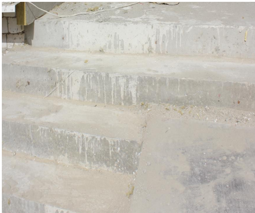
Рис. 5.2. Сходи вхідного вузла 9-ти поверхового житлового будинку
