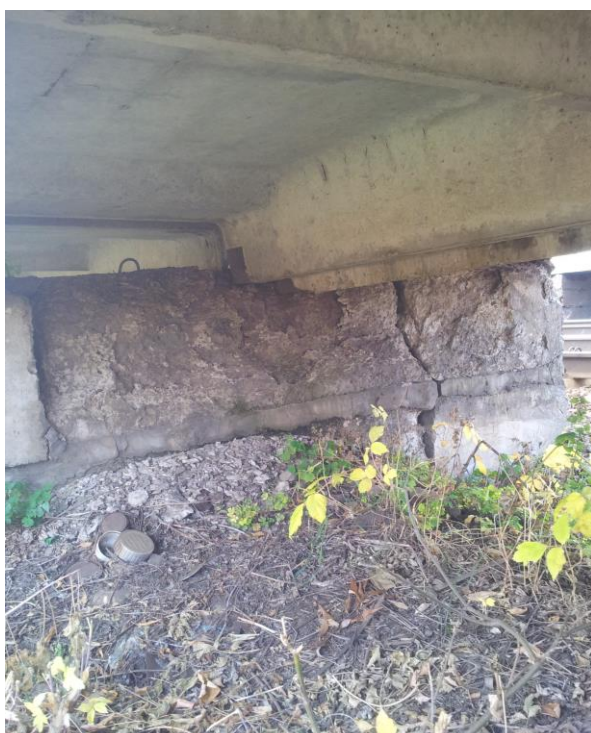
Рис. 5.4 Пошкодження опор високих пасажирських платформ: а – із залізобетонних стояків на з.п. Високий; б, в, г – із бетонних блоків на з.п. Артемівка
