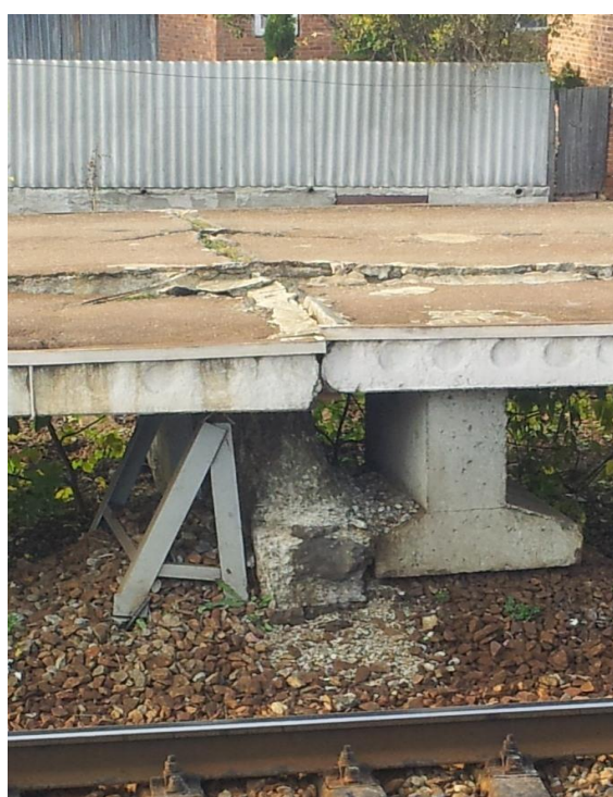
Рис. 5.4 Пошкодження опор високих пасажирських платформ: а – із залізобетонних стояків на з.п. Високий; б, в, г – із бетонних блоків на з.п. Артемівка
