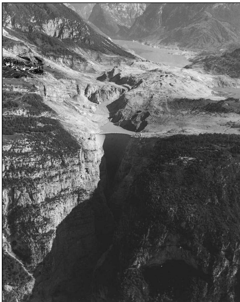
Рис. А.13. Перелив води через гребінь греблі Вайонт, оповзень у водосховище (Італія, 1963 рік)
