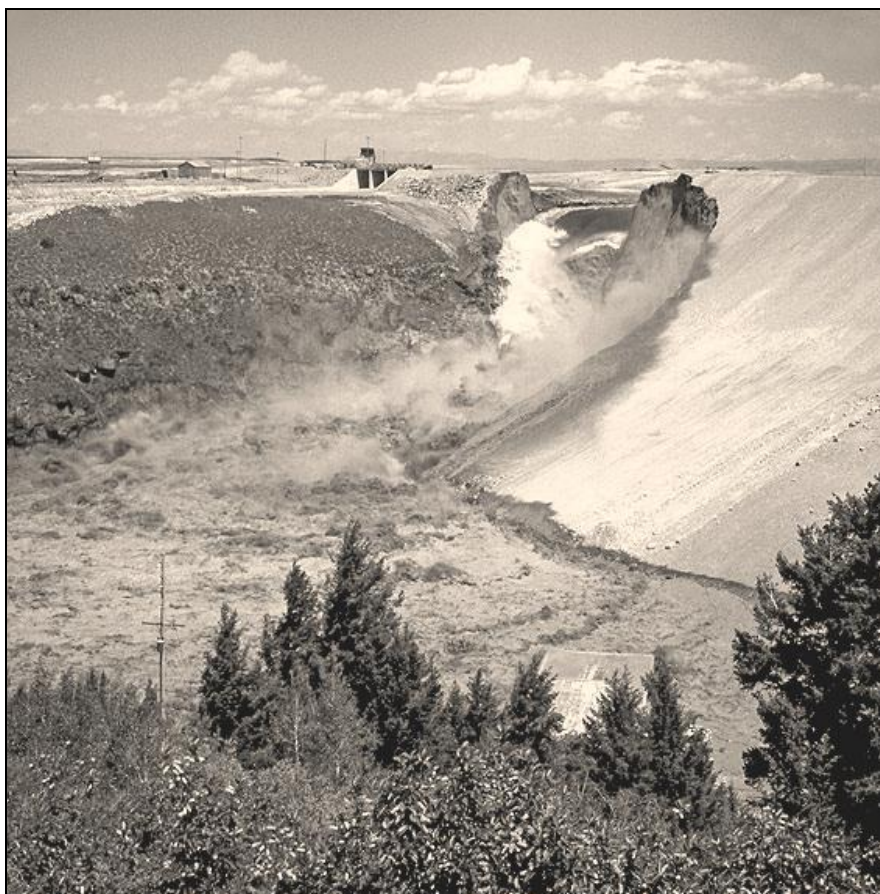
Рис. А.15. Проран на греблі Тітон (США, 1976 рік)
