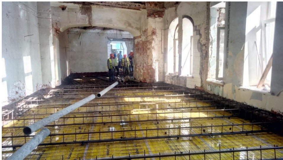
Рис. 1.11. Процес збирання бетоновода при бетонуванні перекриття
