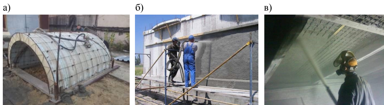
Рис. 1.10. Влаштування тришарових залізобетонних конструкцій з використанням торкрет-установок: а) бетонування криволінійних поверхонь, б) стін, в) перекриттів
