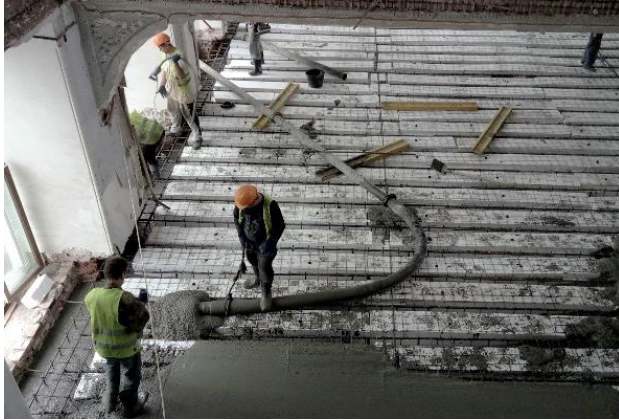
Рис. 4.10. Плита перекриття (об'єкт натурального випробування) в процесі бетонування (а) та перед випробуванням (б)
