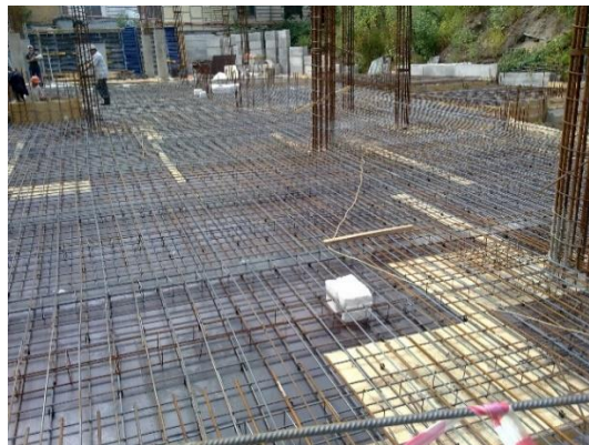
Рис. 1.9. Приклад армування пустотілого (а) і суцільного (б) перекриття
