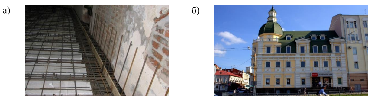
Рис. 2.9. Торгово-офісний будинок по вул. Римарській, 2, м Харкові: а) процес армування фундаментних плит з вкладишами; б) введений в експлуатацію об'єкт
