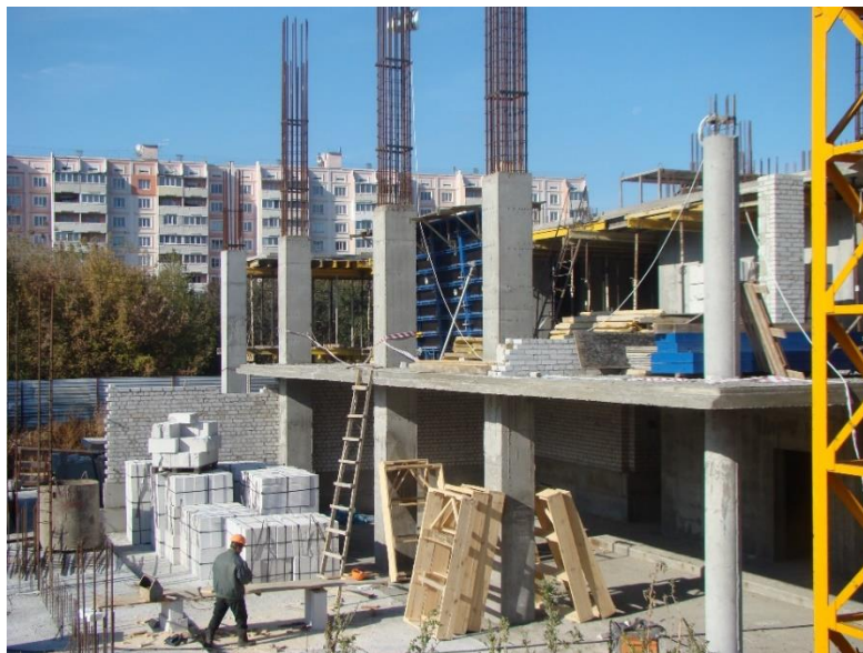
Рис. 5.12. Температурний шов в осях «8-9»
