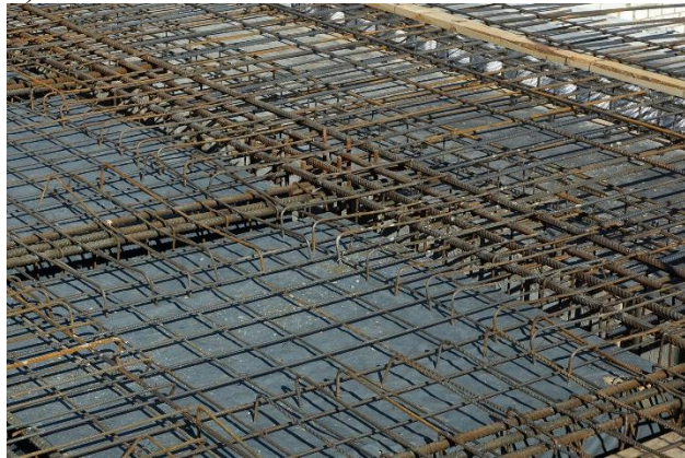
Рис. 1.9. Приклад армування пустотілого (а) і суцільного (б) перекриття
