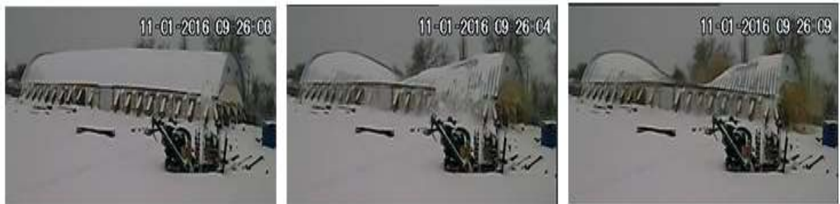
Рис. 1.12. Покадрова фіксація обвалення споруди довжиною 60 метрів менш ніж за 10 секунд
