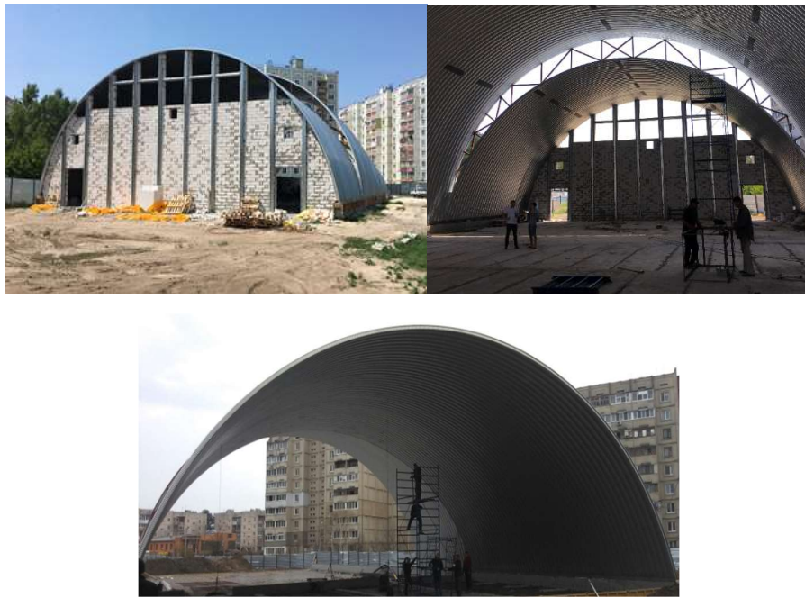
Рис. 4.2 Натурні фото споруди, що досліджували на різних етапах будівництва та експерименту;
