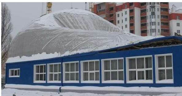
Рис. 1.11. Обвалення покриття спорт-комплексу, м. Вишневе, Україна.
