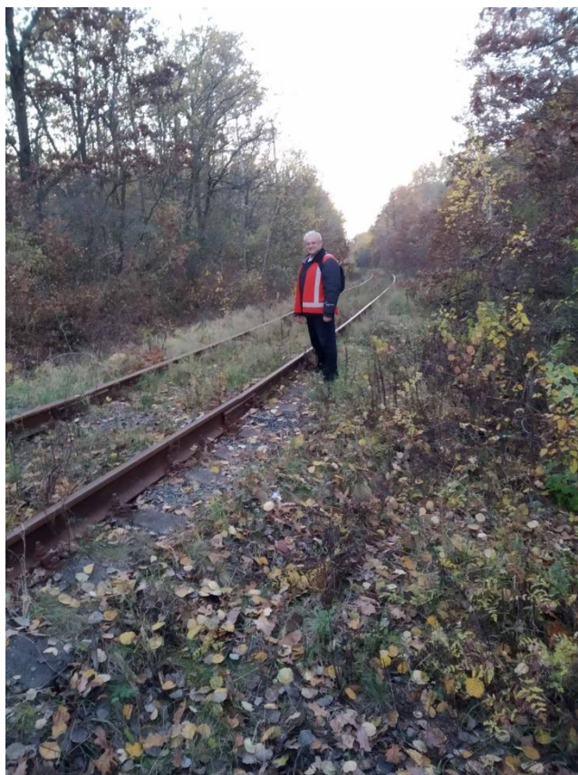
Обстеження під'їзних залізничних колій доцентом кафедри будівельних матеріалів, конструкцій та споруд С.В. Мірошніченко
