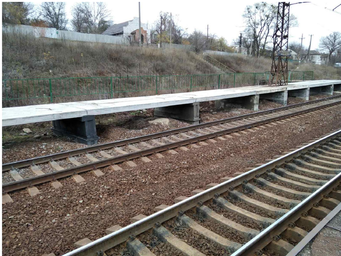
Рис. 5.8 Загальний вигляд опор пасажирських платформ з екранами
