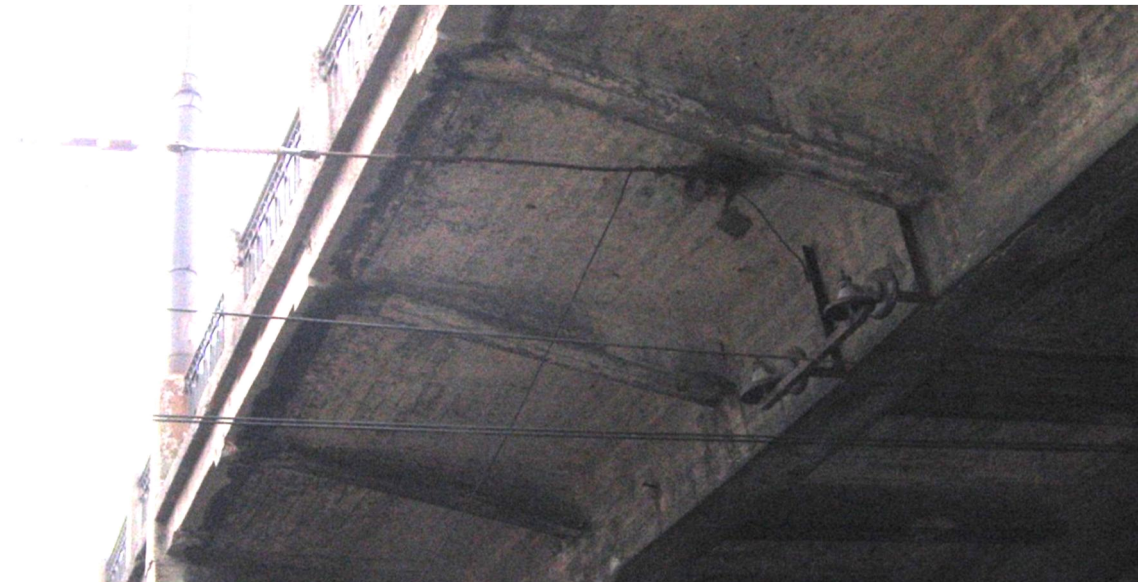
Рис. В.12 Автодорожній шляхопровід на 6 км ПК1 дільниці Основа – Харків-Левада (вул. Молочна, м. Харків): а – загальний вигляд шляхопроводу; б – кріплення несучого тросу контактної мережі до прогонових споруд
