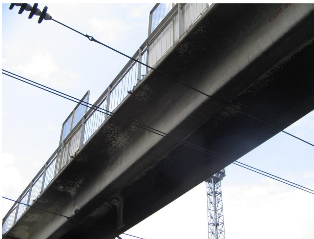
Рис. Б.3 Балкон вокзалу та пішохідний міст ст. Харків-пас.: a – асфальтобетонне покриття балкону; б – розташування контактної мережі під прогоновими будовами пішохідного мосту.
