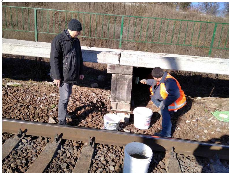
Рис. 5.6 Улаштування екранного захисту опор пасажирських платформ: а – шпаклювання нерівностей; б, в – нанесення композиції прийомами малярних робіт (щіткою)
