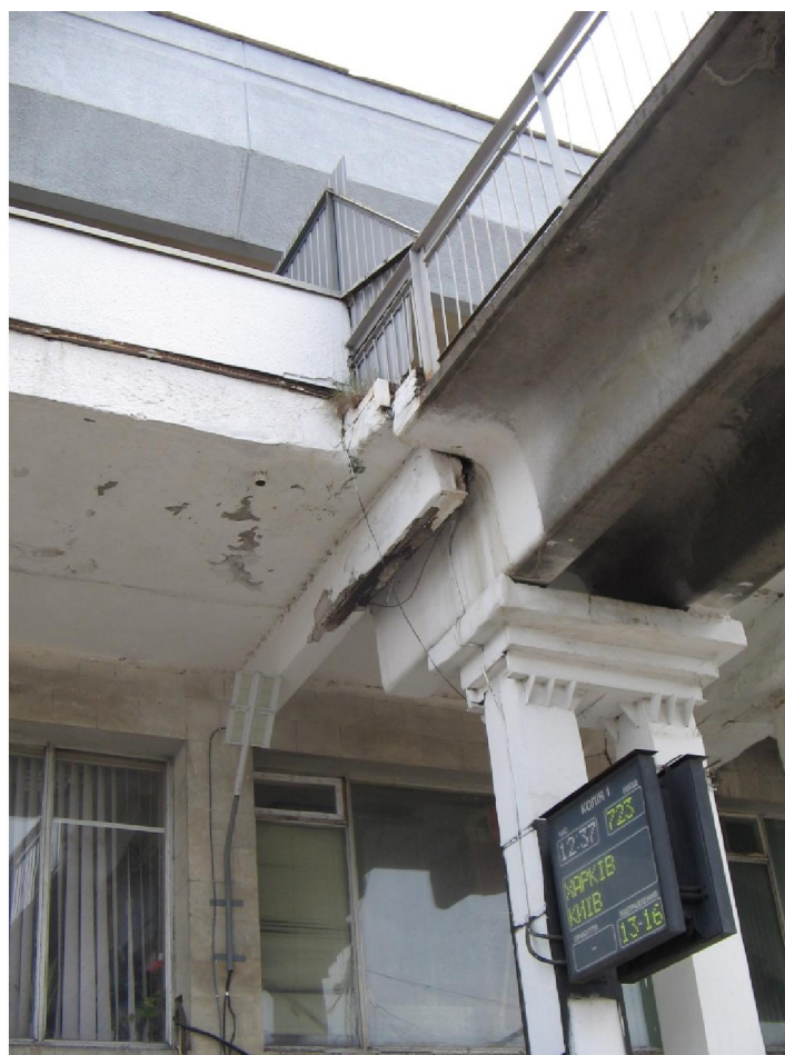
Рис. Б.2 Балкон 2/3-поверхового крила вокзалу Харків-пас.: б – пішохідний міст; б – сполучення балкону з пішохідним мостом
