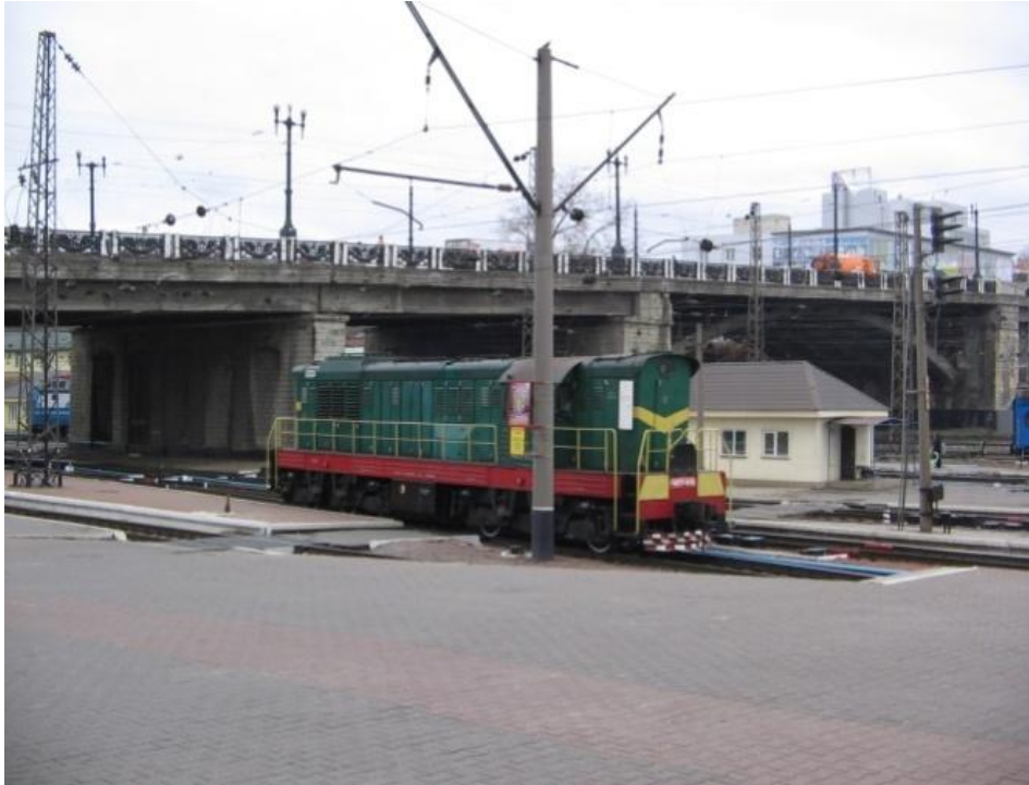
Рис. В.4 Загальний вигляд шляхопроводу ім. М.Караєва на ділянці Козача Лопань – Харків зі сторони ст. Харків-пас.
