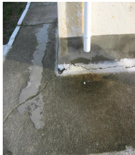
Рис. 1.3 Електрокорозійне пошкодження конструкцій будівлі вокзалу: a – схема протікання струму через конструкції: 1– електрифікована колія; 2– будівля (на б – перон); 3 – сирий підвал; 4– горизонтальна гідроізоляція; 5 – заземлене електрообладнання; 6– рівень ґрунтових вод; 7– атмосферні опади; 8– блукаючий струм, що переважає в суху погоду; 9– блукаючий струм, що переважає у сиру погоду; б – пошкодження цоколю будівлі вокзалу від атмосферних впливів, прискорені впливом струмів витоку
