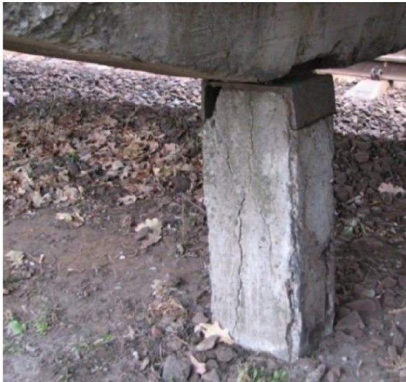
Рис. 1.4 Електрокорозія залізобетонних стояків високих пасажирських платформ: a – схема протікання струму витoku крізь конструкції платформи і заземлення металеві огорожі у дощову погоду; б – тріщини у стояках внаслідок електрокорозії арматури; в – схема переносу іонів (та електронів) – носіїв струму крізь обводнений ґрунт і бетон захисного шару до арматури
