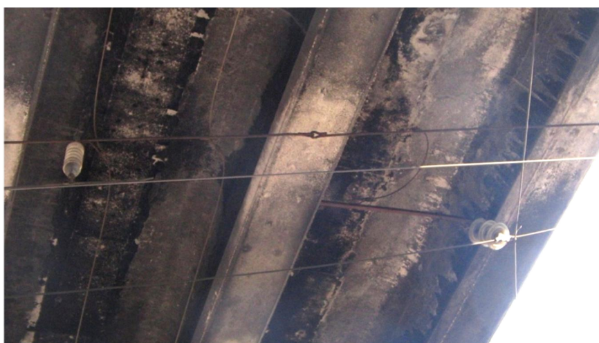
Рис. В.14 Автодорожній шляхопровід на 136 км ПК6 ділянки Дарниця-Полтава: a – загальний вигляд шляхопроводу; б – кріплення несучого тросу контактної мережі до прогонових споруд
