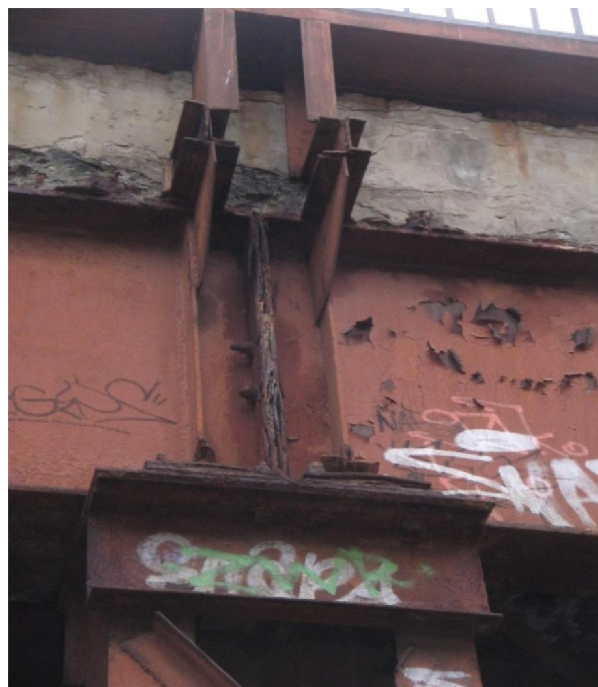
Рис. В.11 Пошкодження конструкцій автодорожного шляхопроводу на 12 км ПКЗ ділянки Харків – Куп'янськ («Корсиковський», Московський проспект, м. Харків)
