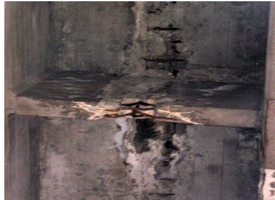
Рис.В.5 Пошкодження конструкцій автодорожнього шляхопроводу на 781 км ПК4 ділянки Козача Лопань – Харків (ім. М.Караєва, м. Харків): а – інтенсивне вилугування бетону балочних прогонових споруд; б – Відшарування захисного шару і корозія арматури на конструкціях шляхопроводу; в – пошкодження діафрагм та корозія їх арматури
