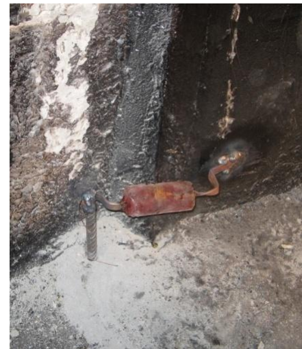
Рис. 1.12 Ремонт і захист конструкції водопропускної труби в залізничному насипу: а – схема протікання струму витoku з рейок через захищену діодним заземленням конструкцію, відремонтовану металоін'єкційною сорочкою; б, в – схема ( б ) та вигляд ( в ) діодного заземлення: 1 – рейкова колія; 2 – металоін'єкційна сорочка; 3 – струми витoku; 4 – вентиль (діод) захисного улаштування; 5 – стержень заземлення; К – катодна зона; А – анодна зона (корозійно небезпечна)
