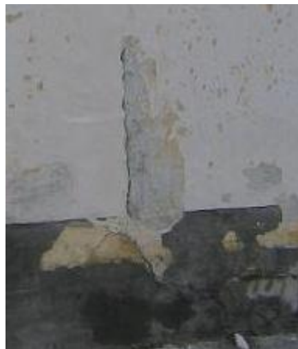
Рис. 1.3 Електрокорозійне пошкодження конструкцій будівлі вокзалу: a – схема протікання струму через конструкції: 1– електрифікована колія; 2– будівля (на б – перон); 3 – сирий підвал; 4– горизонтальна гідроізоляція; 5 – заземлене електрообладнання; 6– рівень ґрунтових вод; 7– атмосферні опади; 8– блукаючий струм, що переважає в суху погоду; 9– блукаючий струм, що переважає у сиру погоду; б – пошкодження цоколю будівлі вокзалу від атмосферних впливів, прискорені впливом струмів витоку
