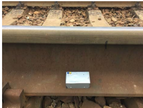
Рис. 3.16. Встановлення пристрою на підшву рейки.
