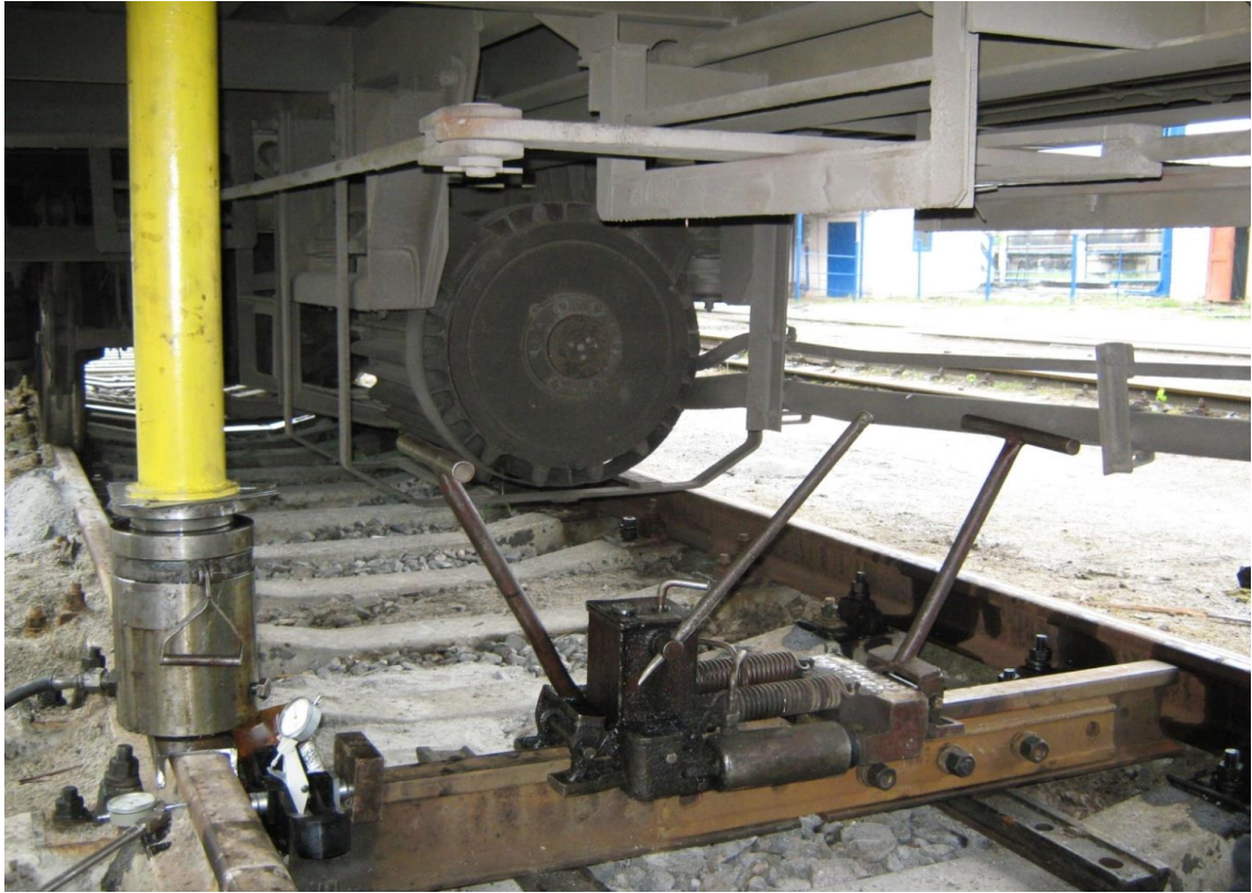
Рис. 2.8. Місце проведення експериментальних робіт з встановленим силовим гідравлічним обладнанням
