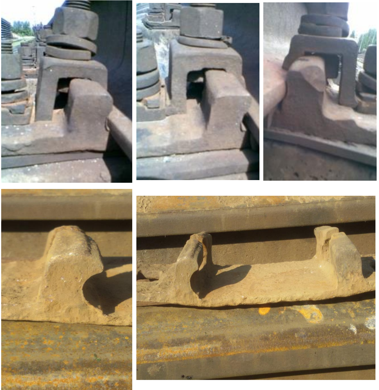
Рис. 2.2. Виробтка зовнішньої реборди підкладок
