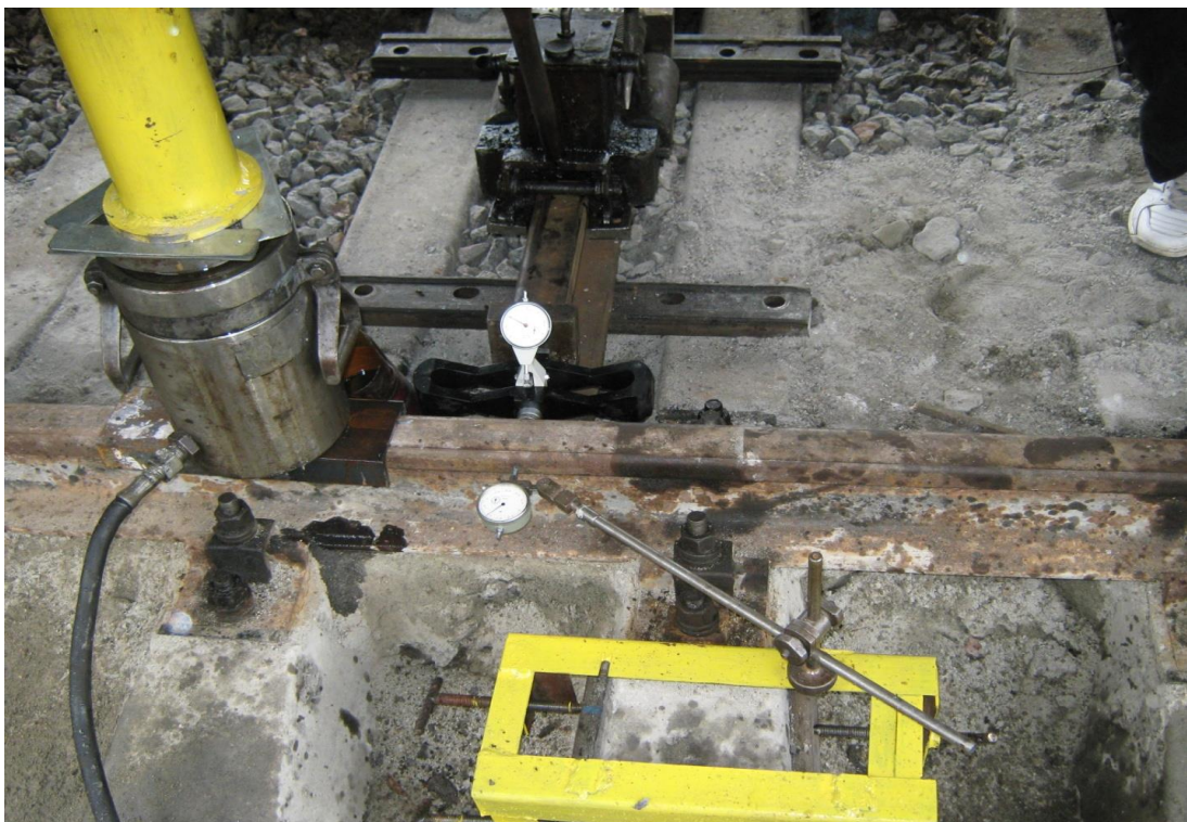
Рис. 2.15. Фіксація індикатора горизонтальних переміщень на спеціальній рамі, закріпленій на залізобетонній шпалі за допомогою струбцин (вид зверху)
