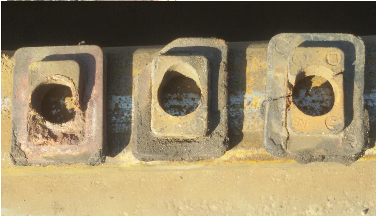
Рис. 2.4. Механічне руйнування ізолюючої втулки через зміщення вздовж та поперек колії їх через повне послаблення закладних болтів ,що приводить до зміщення підкладки як вздовж так і поперек колії
