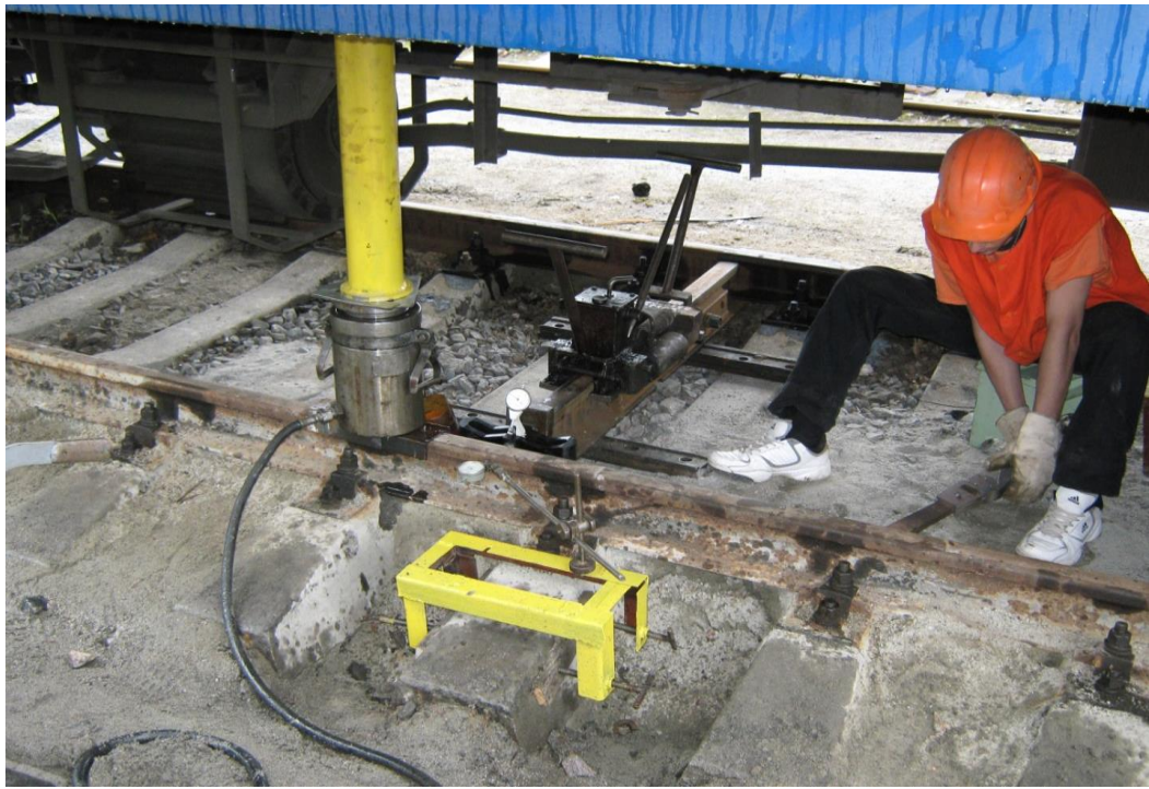
Рис. 2.14. Визначення та встановлення розрахункових зусиль клемних та закладних болтів за допомогою динамометричного ключа конструкції ЦНДІ МШС.
