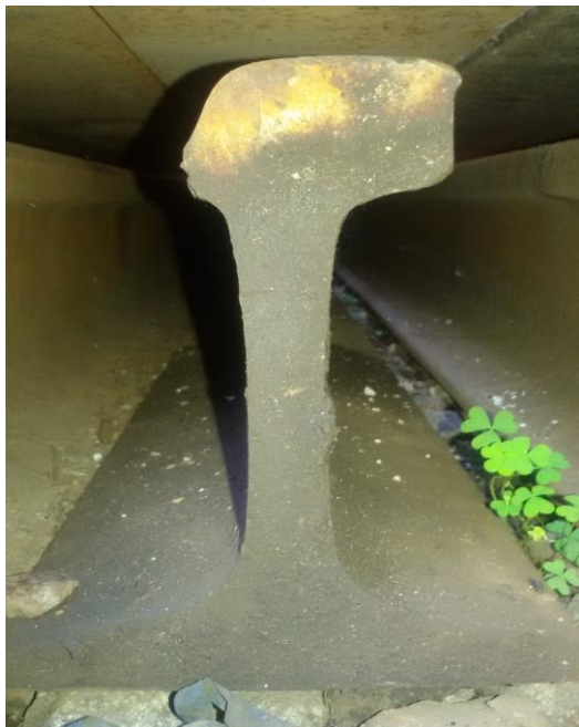
Рис. 4.2. Приклад бічного зносу головки рейки до 10 мм
