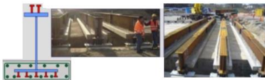
Рис. 1.5. Сталезалізобетонні прогонові будови із застосуванням preflex -балок
