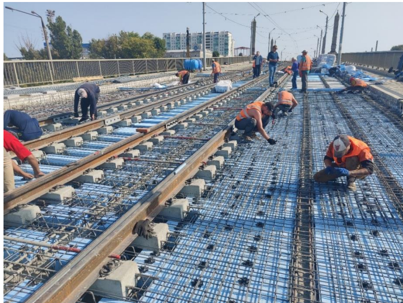
Рис. 5.9. В'язання сіток верхньої обшивки двопоясної плити
