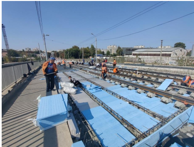
Рис. 5.8. Розкладка пінополістиролу для влаштування порожнин в двопоясній плиті
