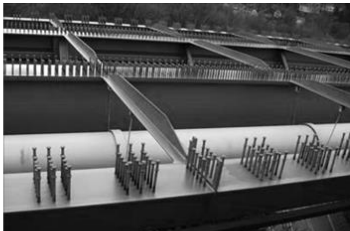
Рис. 1.10. Гнучкі упори типу Нельсон.
