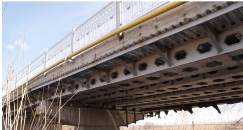
Рис. 4.6. Загальний вигляд прогонової будови (вид знизу).
