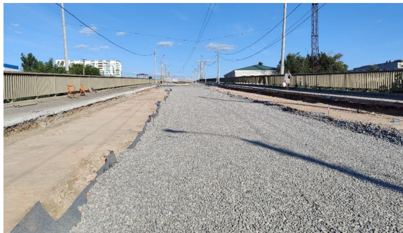
Рис. 5.6. Влаштування основи під залізобетонну плиту.
