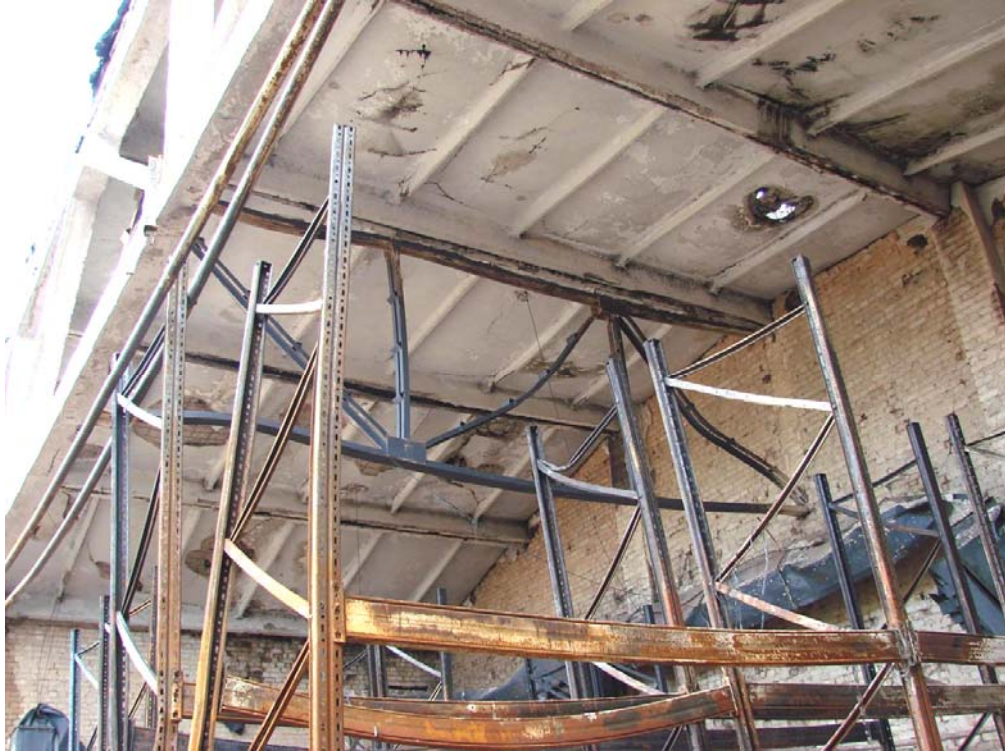
Рис. 2.12. Вигляд залишених конструкцій покриття в зоні пожежі з боку цеху
