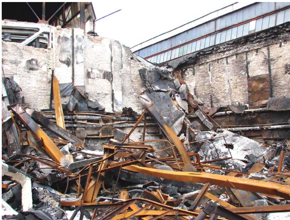
Рис. 2.10. Вигляд обвалених конструкцій з боку цеху
