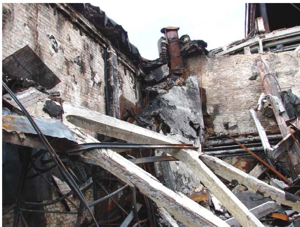
Рис. 2.11. Вигляд обваленної ферми покриття з боку цеху
