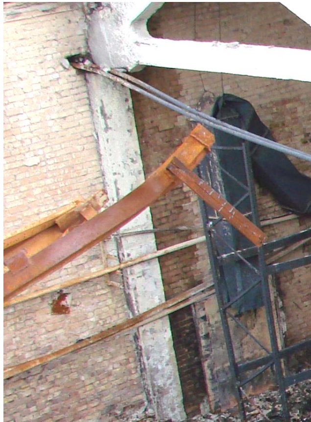
Рис. 2.14. Вигляд колони, ферми і узла обпирання ферми на оголовок колони
