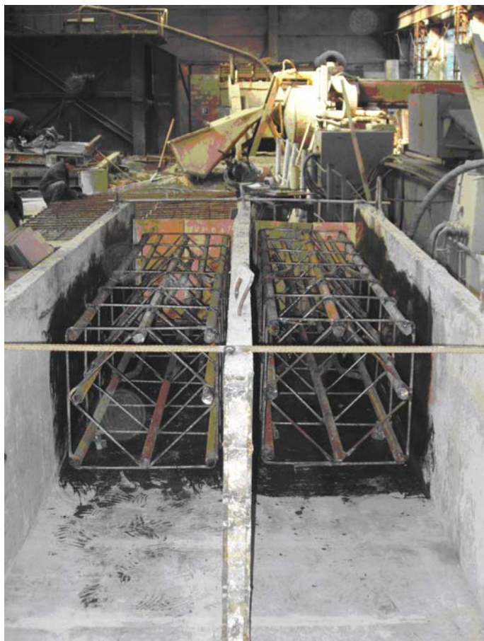
Рис. 3.7. Вигляд встановлених арматурних каркасів в опалубці [59, 120]
