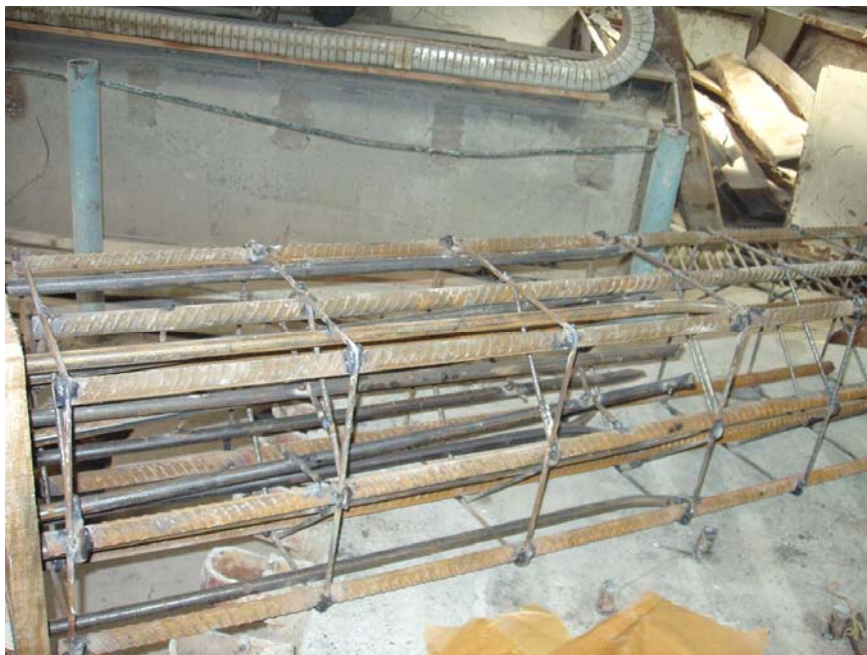
Рис. 3.6. Загальний вигляд арматурного каркасу зразка
