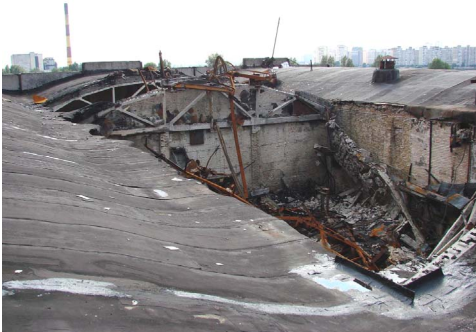
Рис. 2.13. Вигляд обвалених конструкцій з боку покрівлі
