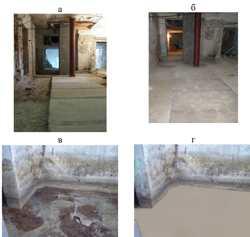
Рис. 6. Фотографії поверхні бетону ростверка: а, в – до нанесення захисного покриття; б, г – захищеного покриттям
