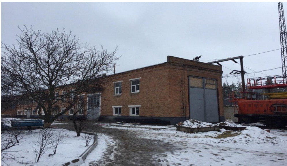
Рис. 1. Загальний вигляд тягової підстанції № 18 м. Зміїв
