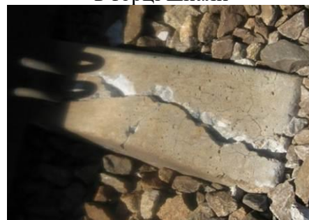
Рис. 4. Основні дефекти (пошкодження) шпал
