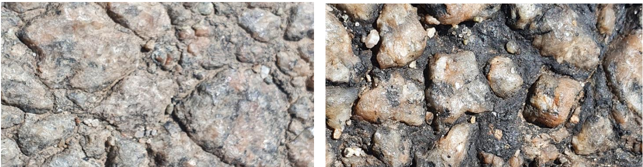
Рис. 4. Поверхня асфальтобетонного покриття до та після обробки омолоджувачем
