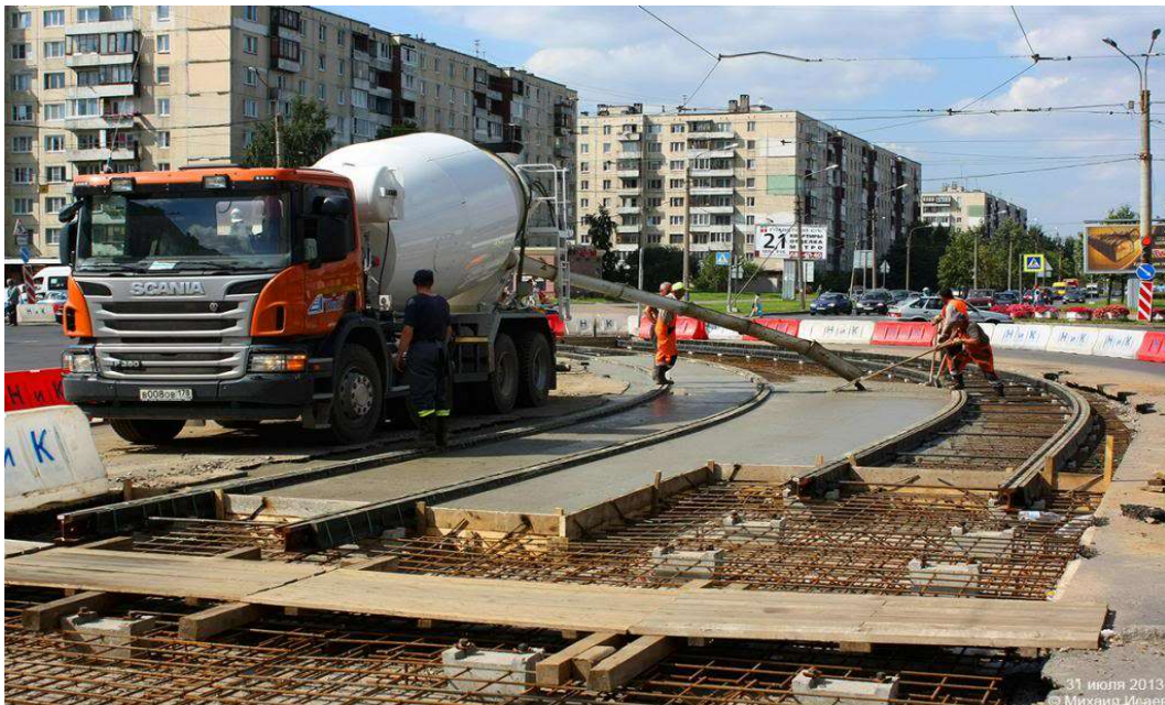
Рис. 6.9 Улаштування трамвайної колії: а – зі збірною підрейковою основою із залізобетонних плит з ізолюваними рейками (м. Харків, просп. Московський, 2016 р.); б – зі збірно-монолітною підрейковою основою із збірних залізобетонних блоків та монолітної плити (м. Харків, вул. Конєва, 2017 р.)
