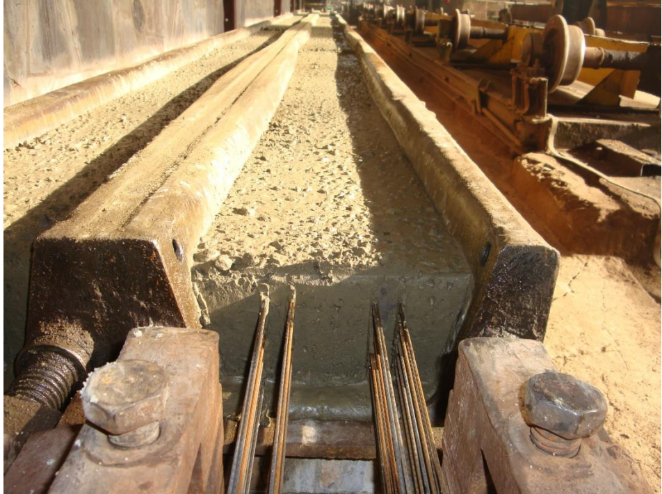
Рис. 1.3 Технологія виробництва залізобетонних шпал: а – укладання бетону в форму; б – ущільнений вібрацією бетон
