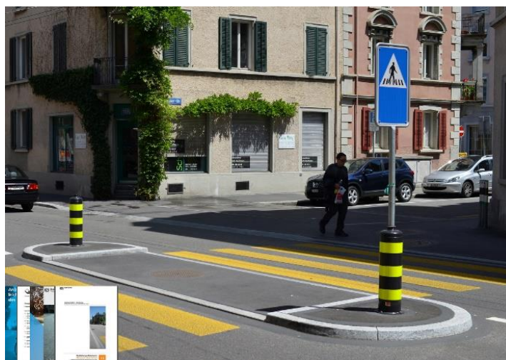
Рис. 2. Зовнішній вигляд острівця безпеки з захисним болардом, Швейцарія
