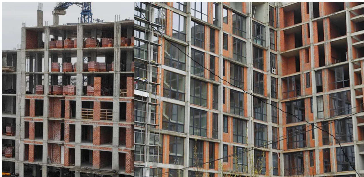
Рис. 2. Каркасні житлові будівлі на стадії зведення
