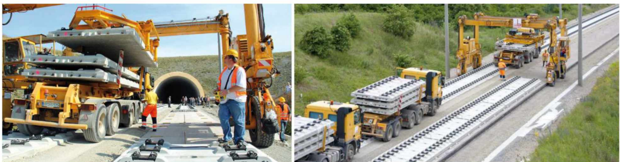
Рис.1 - Укладання плит на ділянці Єдиного транспортного проекту Німеччини
