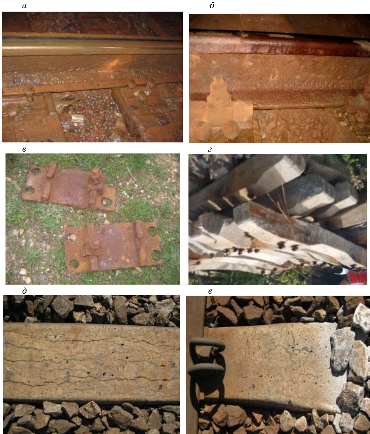
Рис. 4. Електрокорозійні пошкодження елементів верхньої будови колії в тунелях без зворотного склепіння (з природною основною площадкою): Бескидському (старому) Львівській залізниці (а), Сухарному Придніпровської залізниці (б, в) і на ділянці Основа – Букине Південної залізниці (г–е): а – шийки та підосви рейки, костильного скріплення Д0; б – шийки та підосви рейки, клемно-шурупного скріплення Д2; в – підкладок скріплення Д2; г – арматури залізобетонних шпал типу СБ3; г–е – бетону шпал типу СБ3
