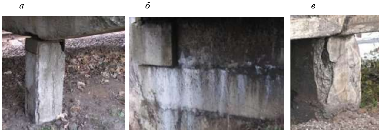
Рис. 5. Електрокорозійні пошкодження опор високих пасажирських платформ на ділянці Харків-Пас. – Мерефа Південної залізниці: а – подовжні тріщини в залізобетонних стояках; б, в – патьоки вилуговування ( б ) і руйнування ребер ( в ) бетонних опор
