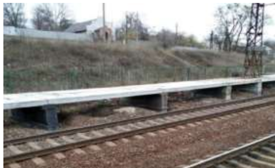
Рис. 12. Конструктивно-технологічне рішення захисту опори пасажирської платформи з заземленим екраном з електропровідної композиції:
