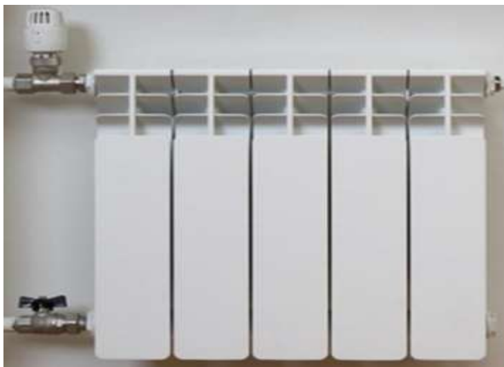
Рис. 5. Фрагмент установлення нового біметалевого приладу опалення і термостатичного клапана з термостатичним елементом
