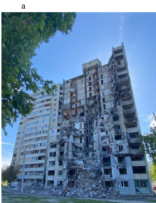
Рис. 1. Приклади руйнування панельної забудови міста Харків: а – обвалення несучих конструкцій будівлі від рівня покрівлі до фундаментів; б – руйнування несучих конструкцій 4-6 поверхів
