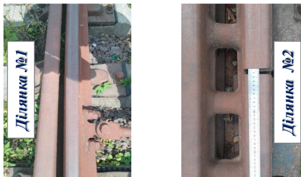
Рис. 3. Характерні ділянки на стрілочному переводі, які викликають значні збурення пневматичної ресори
