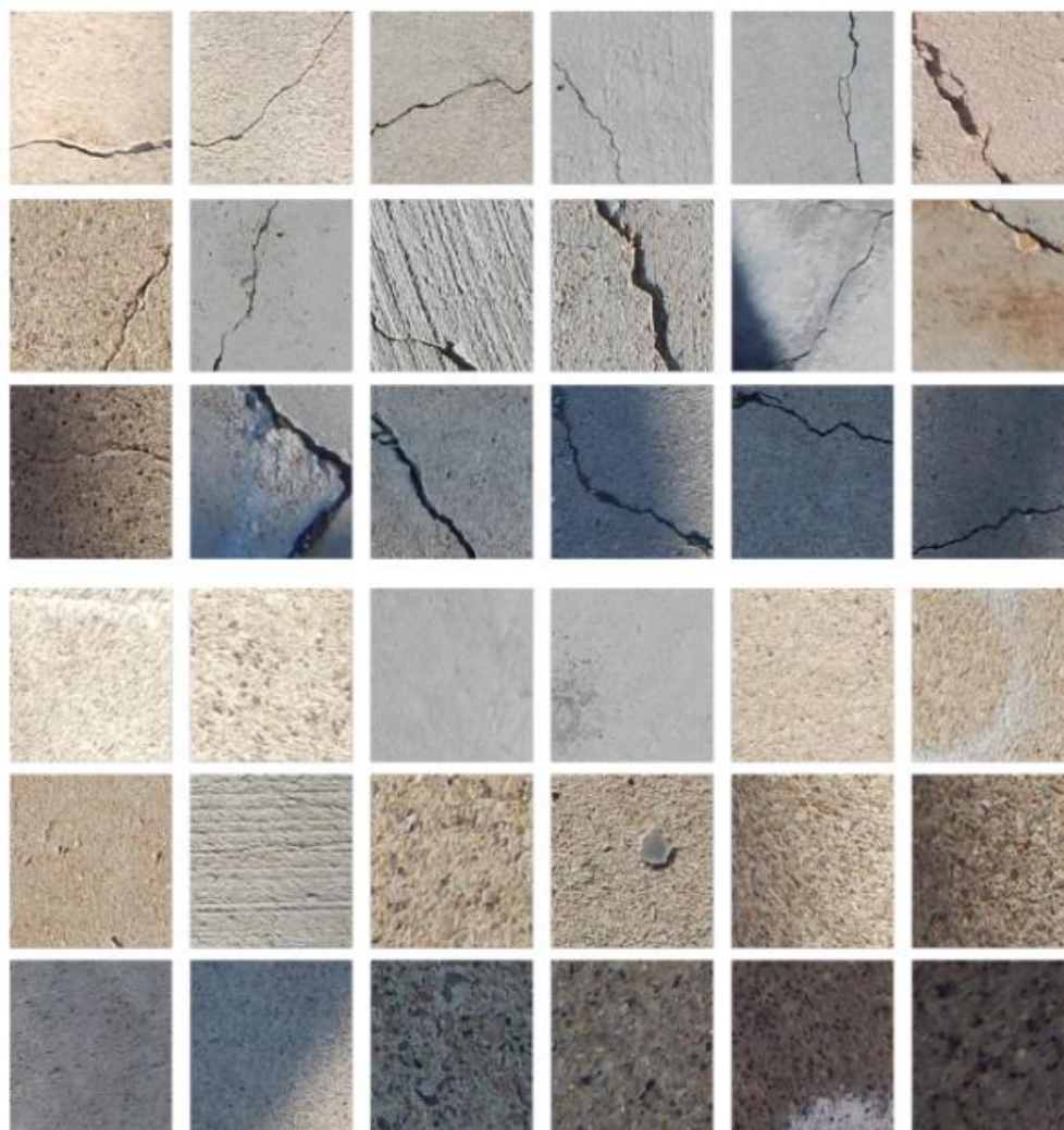
Рис. 3. Приклади зображень, що використовують для навчання: зображення з тріщинами (перші три рядки) і зображень без тріщин (останні три рядки) [4]
