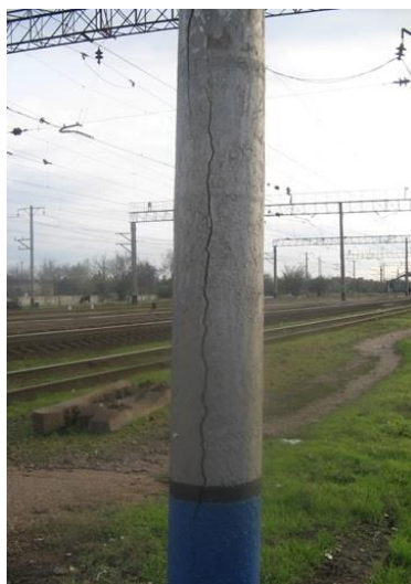
Рис. 3. Подовжні тріщини в опорах від корозії подовжньої арматури
