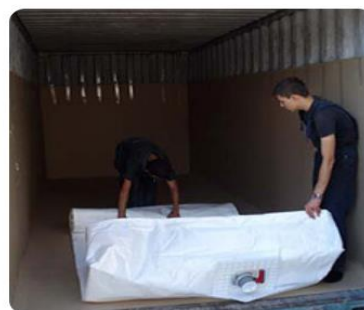
Рис. 3. Підготовка контейнера та укладання флексітанка в контейнер
