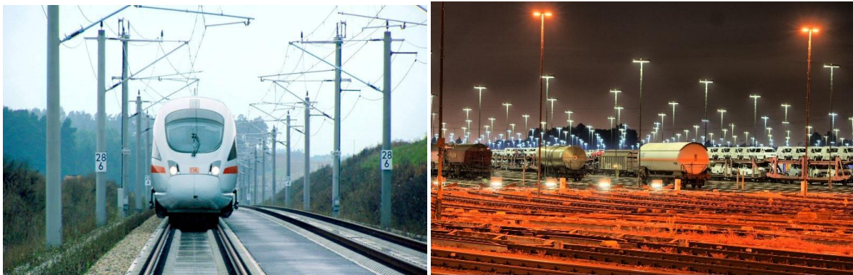
Рис. 1. Приклади суцільних сталевих опор
