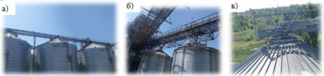
Рис. 1. а) Розташування транспортних галерей; б) траверси галерей; в) опорне кільце силосної башти
