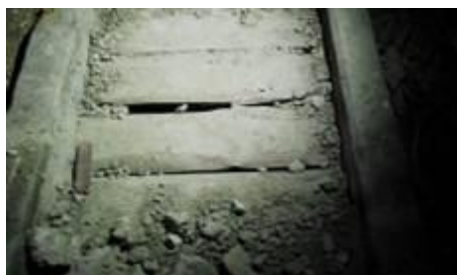
Рис. 2. Розкриття горищного перекриття
