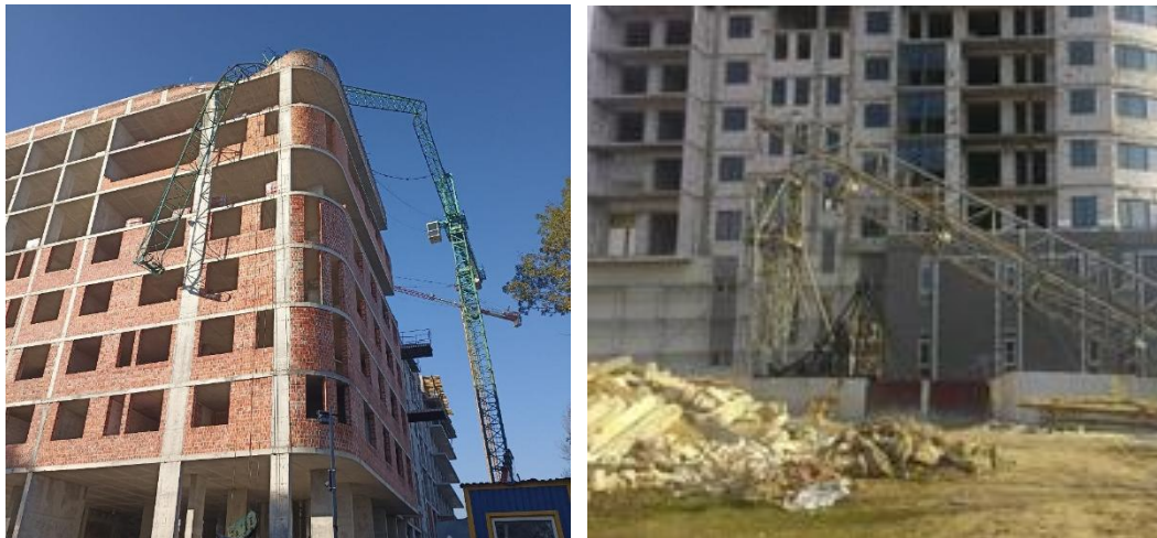
Рис. 1. Аварії баштових кранів із руйнуванням: стріли (м. Львів, 24.10.2024) і башти (м. Рівне, 16.03.2016)
