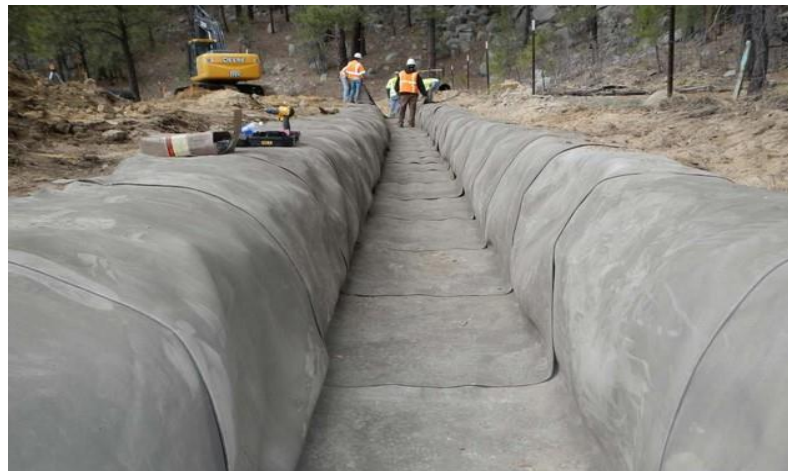
Рисунок 1.7 – Матеріал Concrete Canvas – Бетонний килим (a) та його застосування для укріплення водовідвідних каналів (б) [76]
