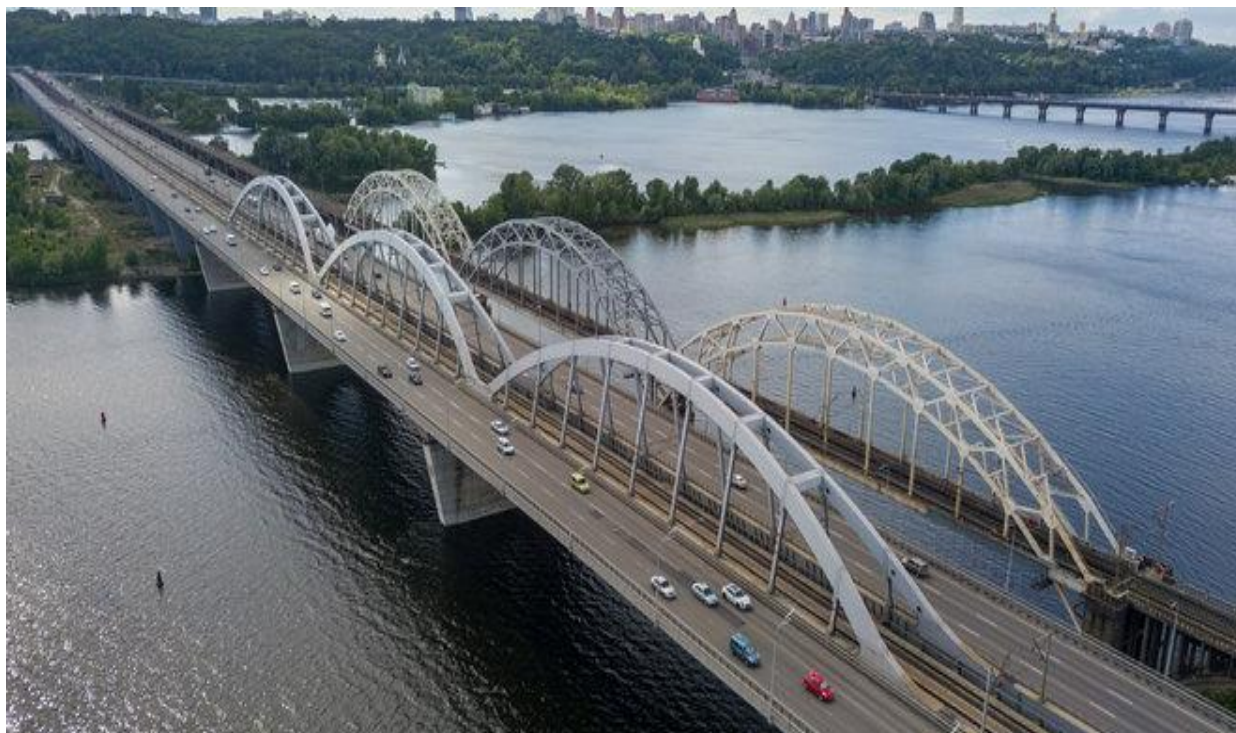
Рисунок В.1 – Дарницький міст у м. Київ, на першому плані – новий залізнично-автодорожній, на другому плані – старий залізничний. Руслові прогони – сталеві ферми, берегові прогони – балкові металеві (нового мосту) та залізобетонні (старого мосту)
